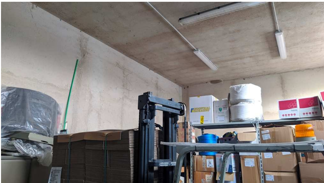
Autorimessa, pareti laterali e soffitto al grezzo, con corpi illuminanti al neon
