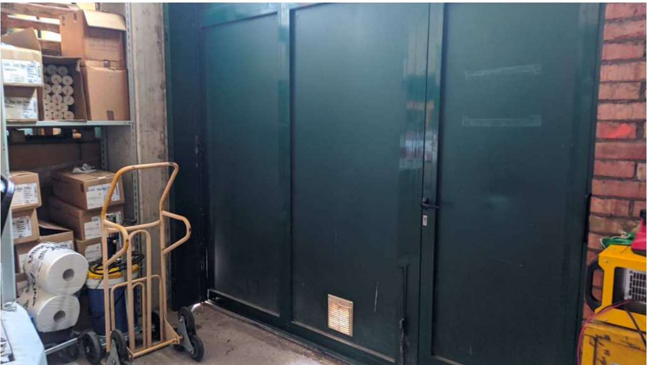
Autorimessa, portone (dettaglio)
