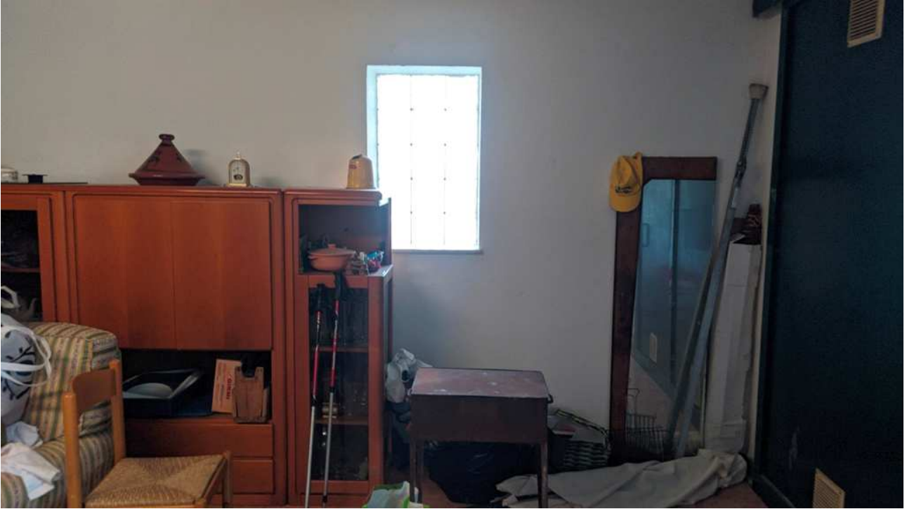
Infisso fisso sulla facciata principale dell'edificio
