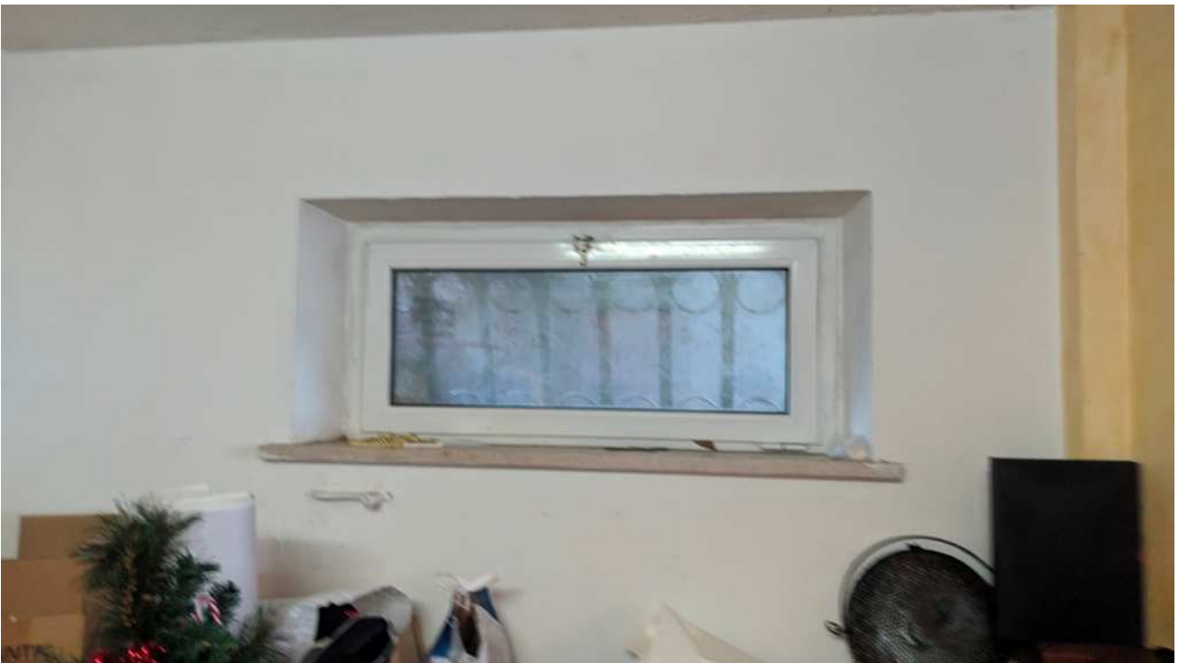
Infisso fisso sulla facciata principale dell'edificio
