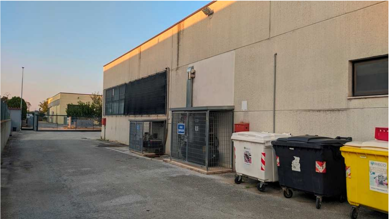
Parete laterale dell'edificio destinato a laboratorio e magazzino
