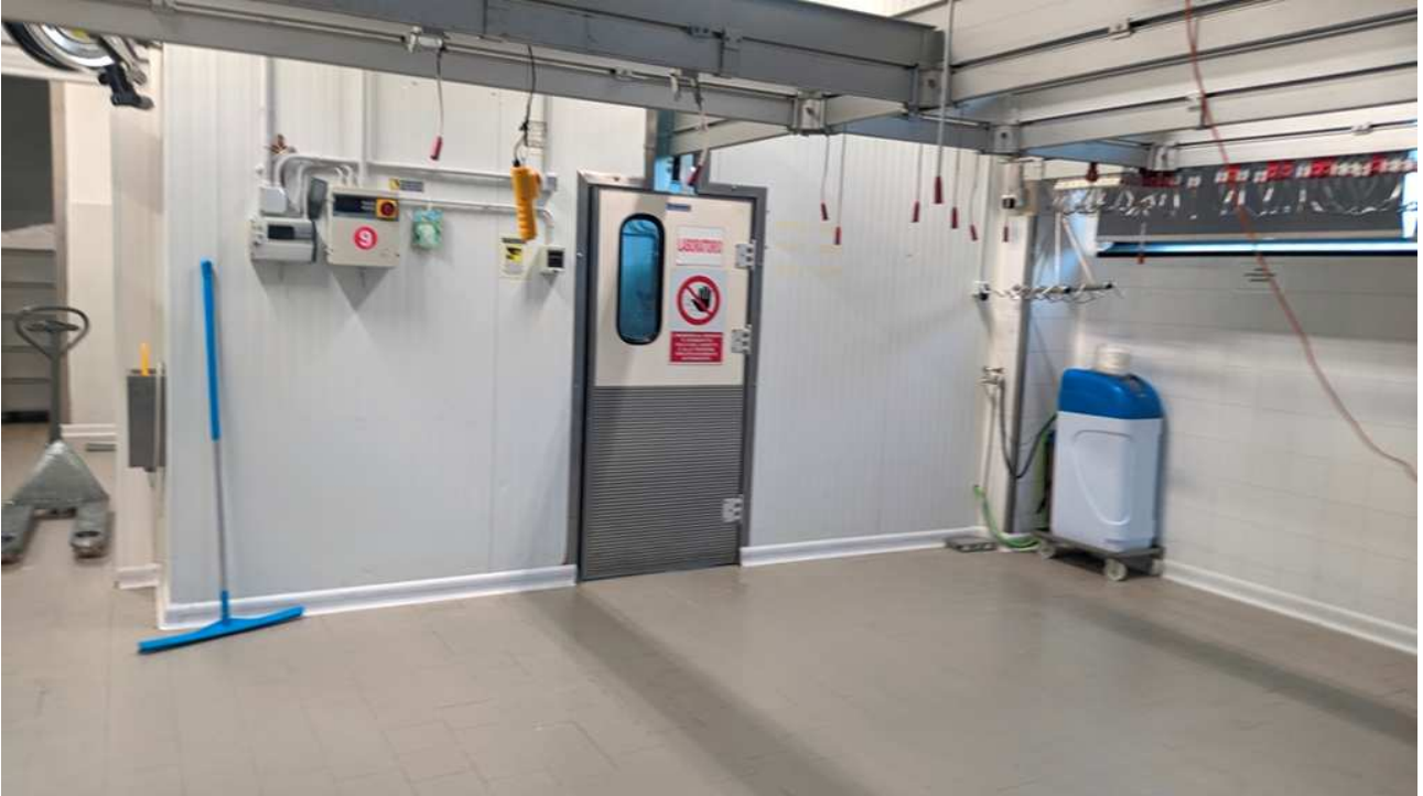
Zona laboratorio con celle frigorifere
