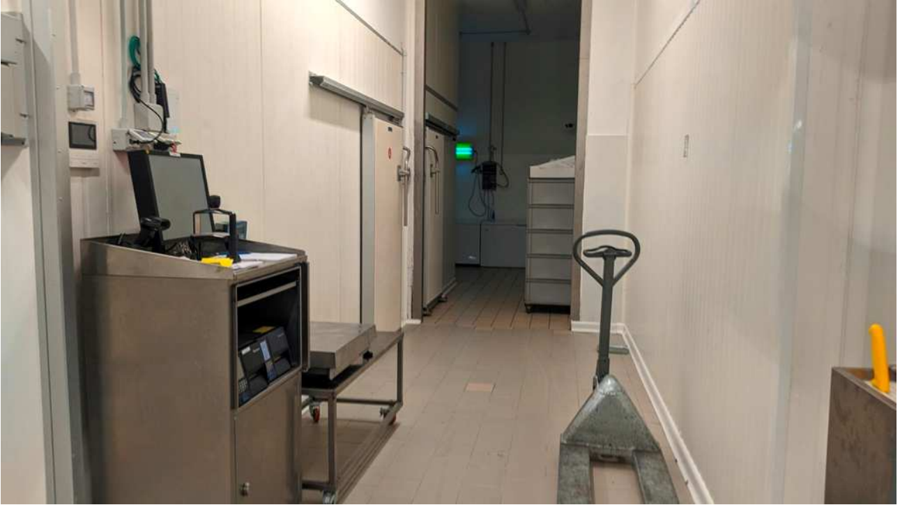
Corridoio di passaggio tra laboratorio e magazzino (nello stesso capannone)
