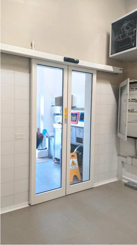
Ingresso alla parte destinata a laboratorio
