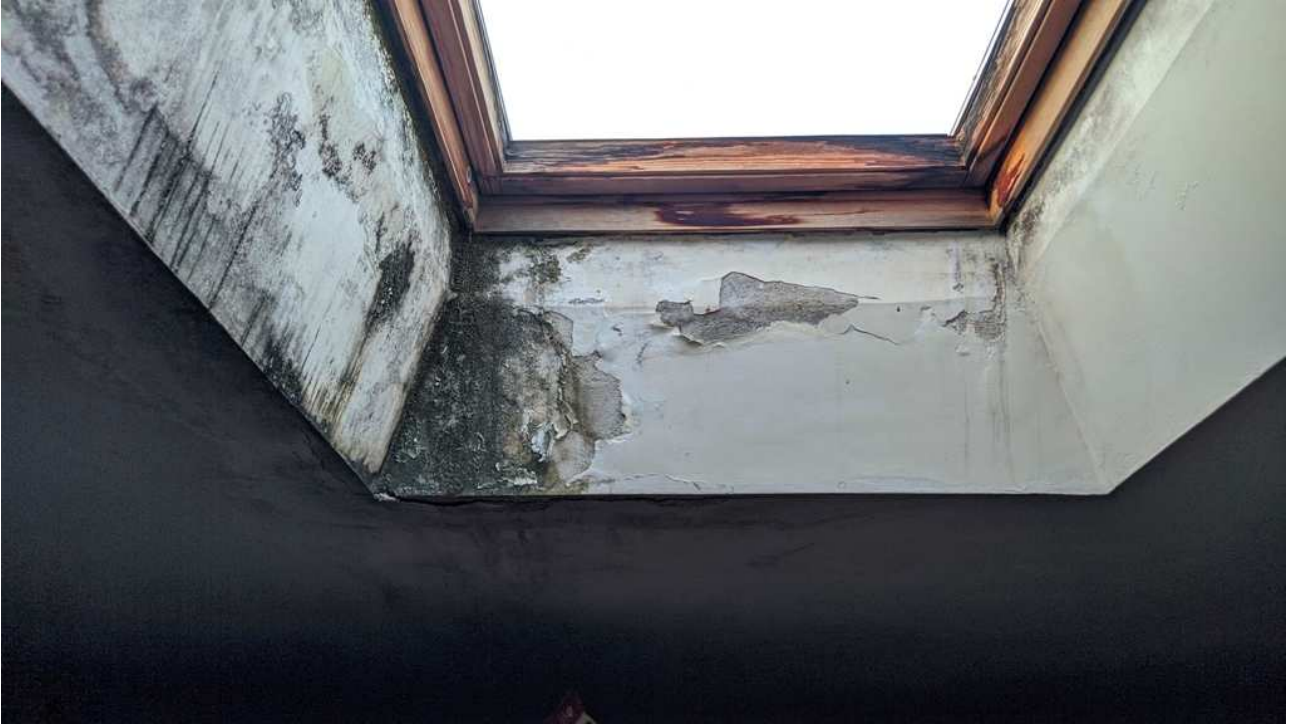
Finestre a tetto, tipologia velux
