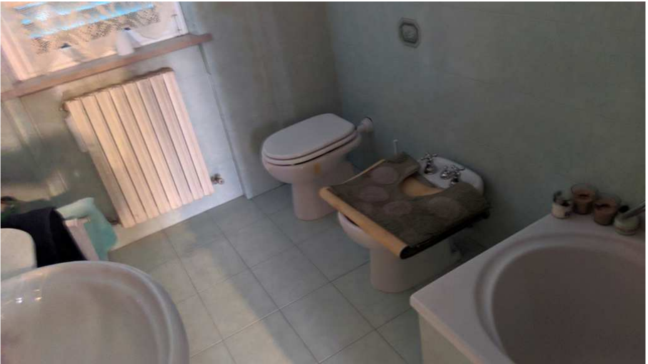
Locale bagno con vasca
