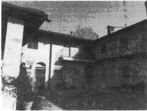
particolare ristorante e abitazione al piano primo
