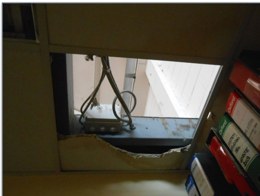
Foto 18 ufficio 4 particolare del soffitto
