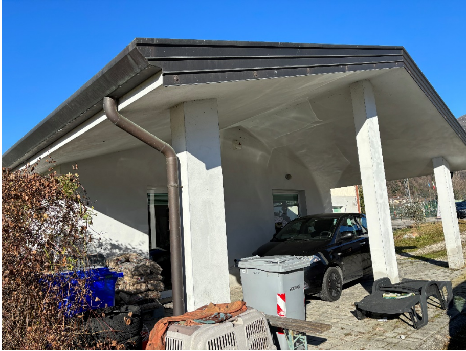
Vista esterna Laboratorio
