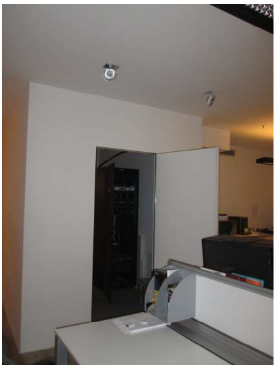
9) locale al PS1
