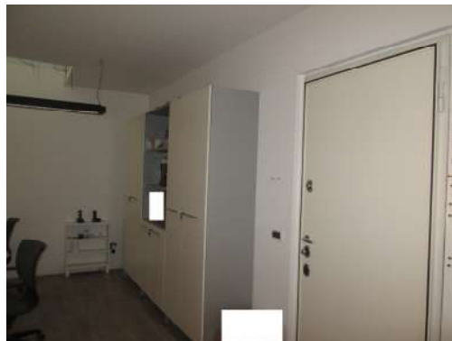
5/6) Accesso e locale PS1
