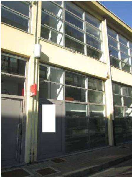
1) Accesso dall'esterno fabbricato
