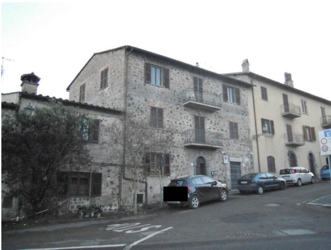
vista esterna dell'appartamento al piano 2° (ultimo)
