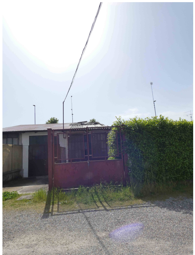
Foto 4. Accesso al box autorimessa
