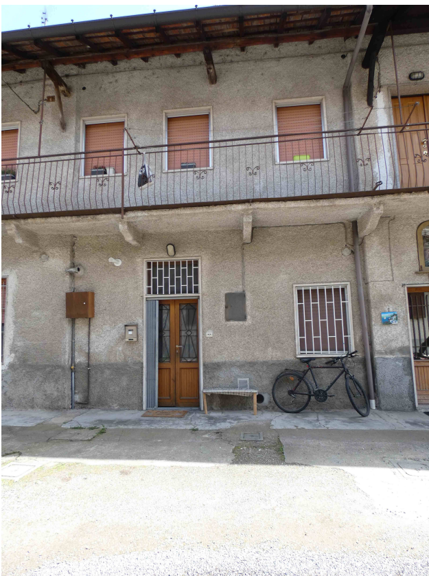
Foto 3. Porta d'accesso all'appartamento
