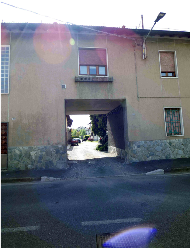
Foto 1. Accesso al civico 28 di Via Roma
