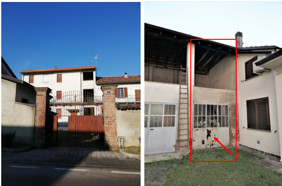
Accesso carrabile alla corte civico 136 e deposito con sovrastante fienile
