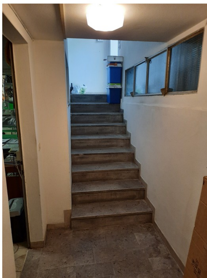
10C - vano scala al piano cantina
