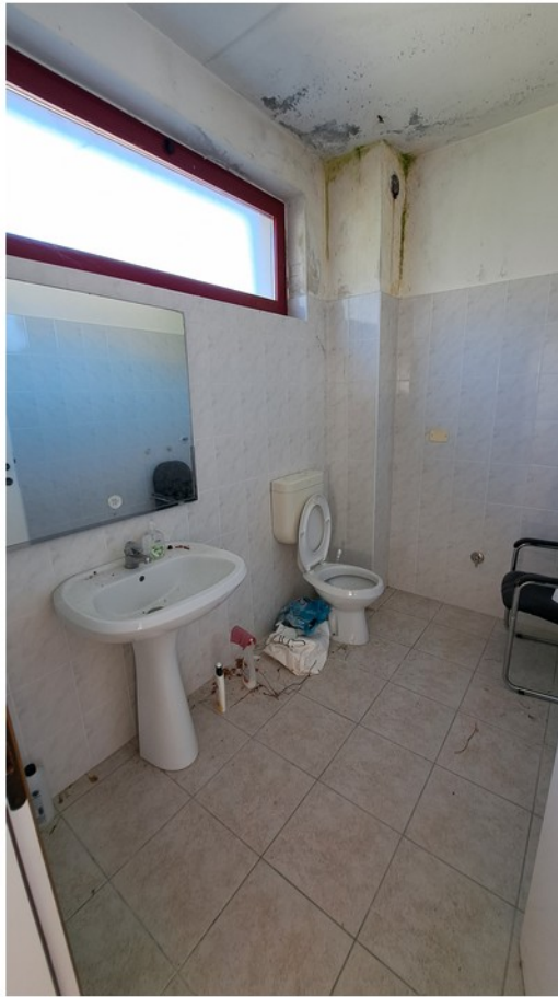
37 - bagno piano primo
