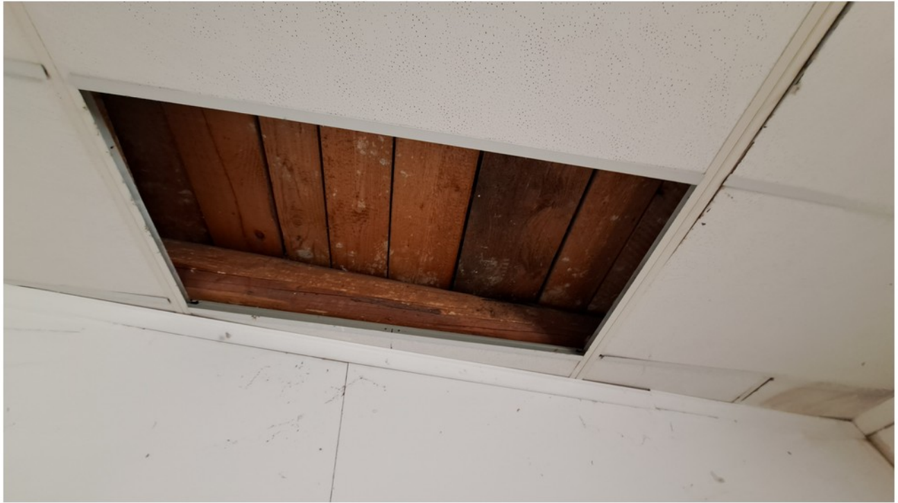
47 - particolare copertura parte vecchia
