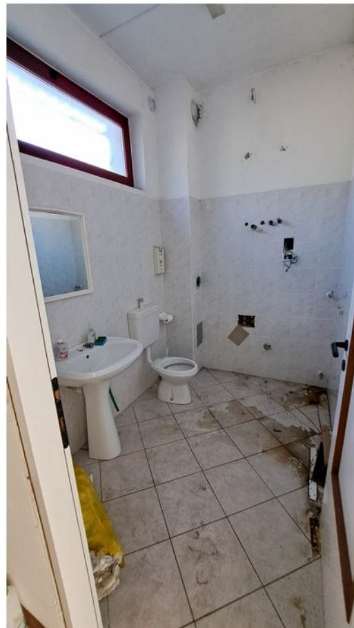
20 - bagno piano terra
