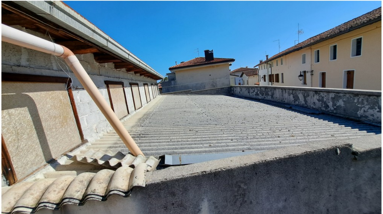
46 - copertura bassa particolare
