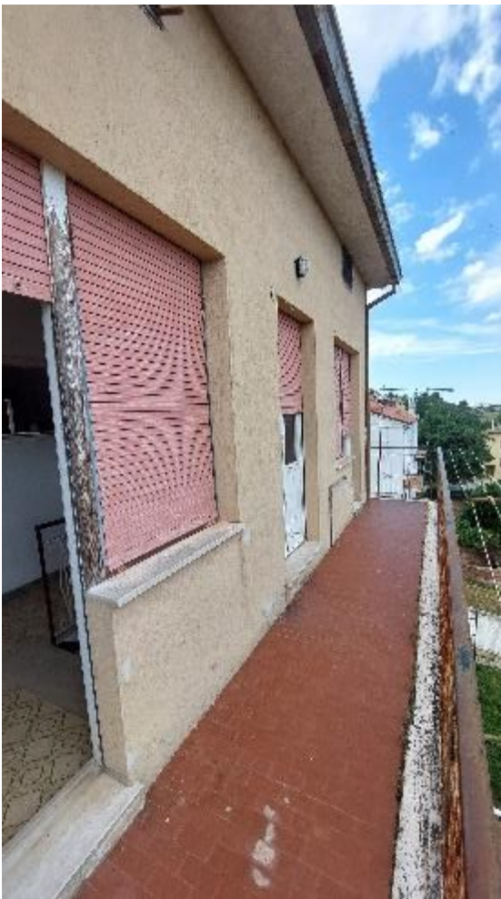
Balcone lato est
