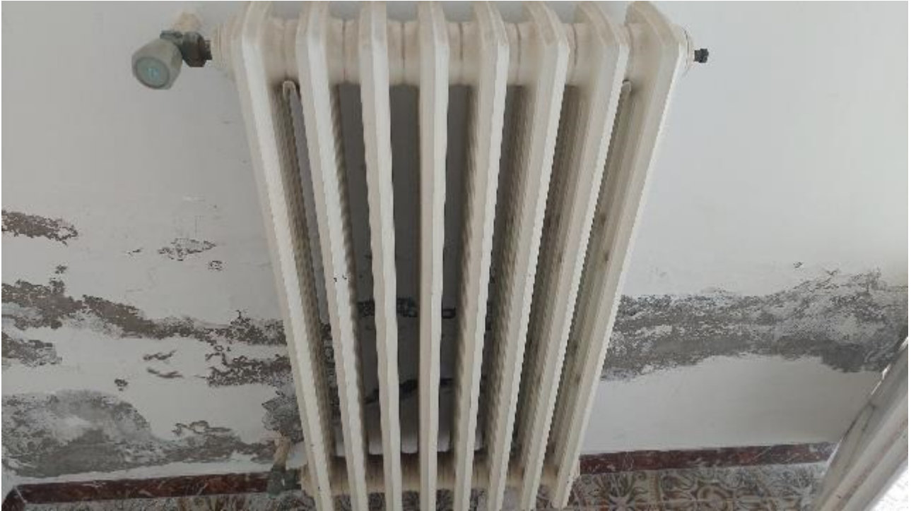
Infiltrazioni camera 1
