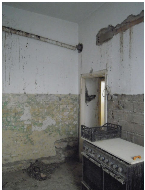
FOTO 10 – vista della cucina verso la porta
