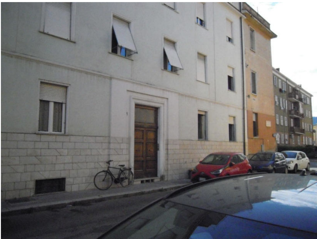
FOTO 2 – vista dell'edificio condominiale da Via Lombardia
