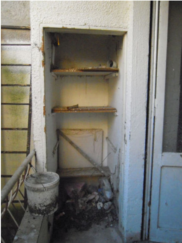
FOTO 11 – vista del terrazzino verso sud
