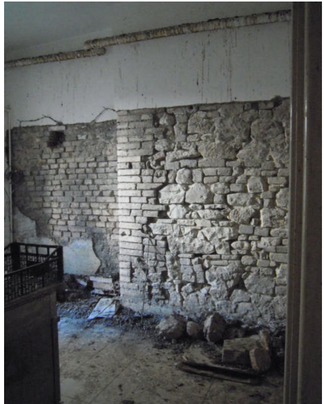
FOTO 8 – vista della cucina dalla porta
