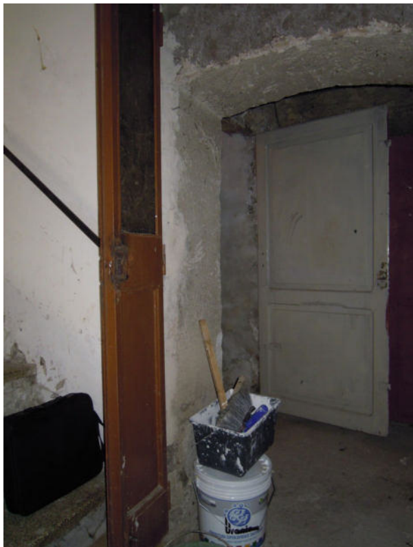
FOTO 17 – vista dell'ingresso alla cantina
