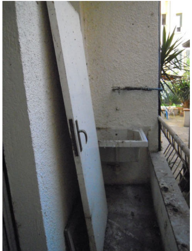
FOTO 12 – vista del terrazzino verso nord
