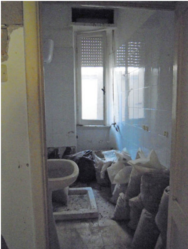
FOTO 7 – vista del WC
