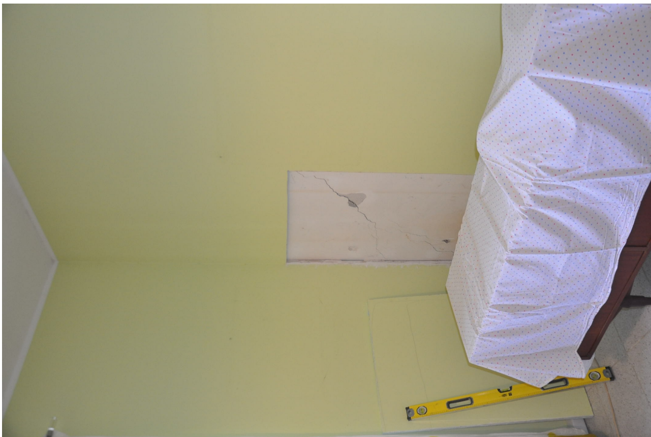
Foto 04 – Individuazione saggi su cartongesso locale Camera
