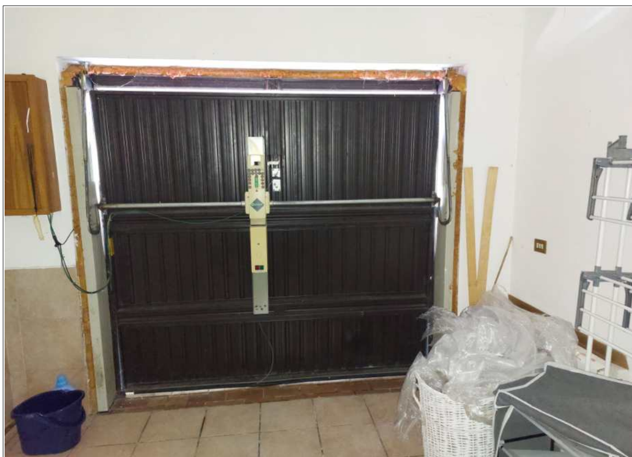
Foto n° 27 – 07/10/2023 - Comune di Sesto al Reghena, foglio 27, part.266, sub.2 – Particolare del portone basculante.
