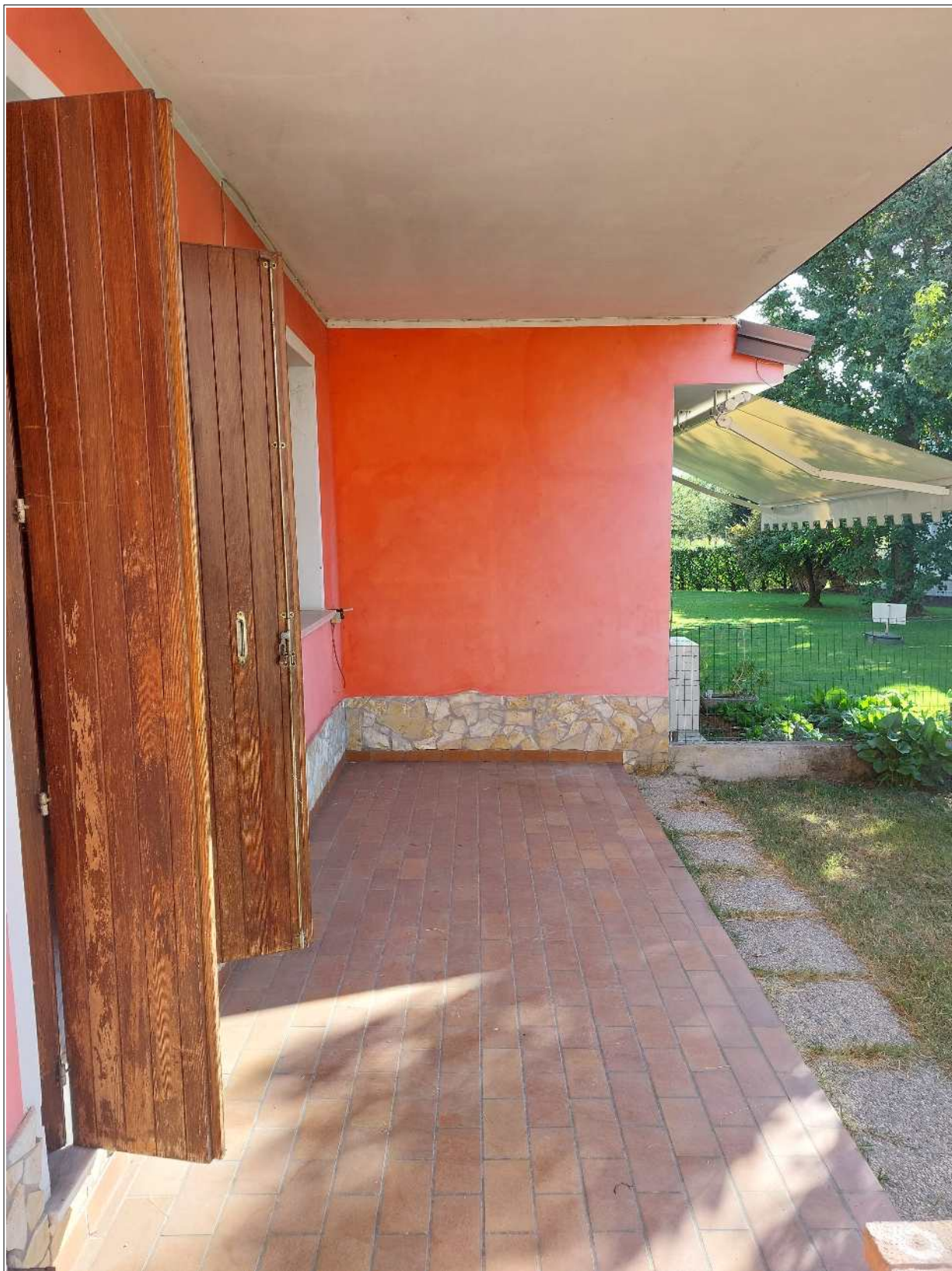
Foto n° 23 – 07/10/2023 - Comune di Sesto al Reghena, foglio 27, part.266, sub.1 – Portico esterno sul retro dell'abitazione.
