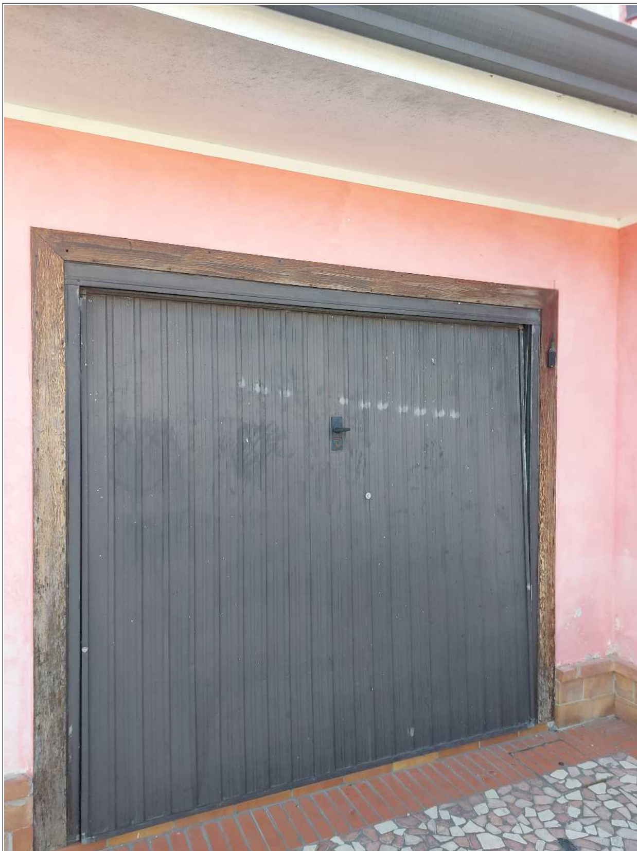
Foto n° 29 – 07/10/2023 - Comune di Sesto al Reghena, foglio 27, part.266, sub.2 – Portone basculante del garage.
