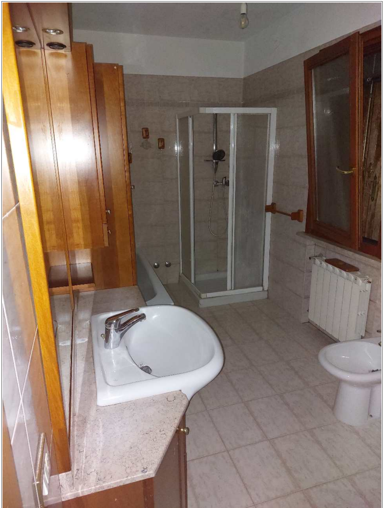
Foto n° 12 – 07/10/2023 - Comune di Sesto al Reghena, foglio 27, part.266, sub.1 – Bagno al P1.
