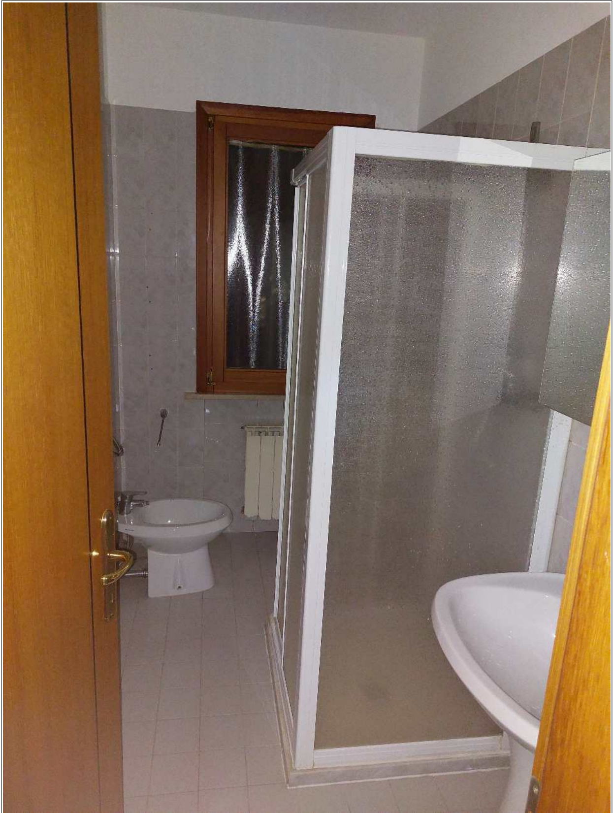
Foto n° 7 – 07/10/2023 - Comune di Sesto al Reghena, foglio 27, part.266, sub.1 – Bagno al PT.
