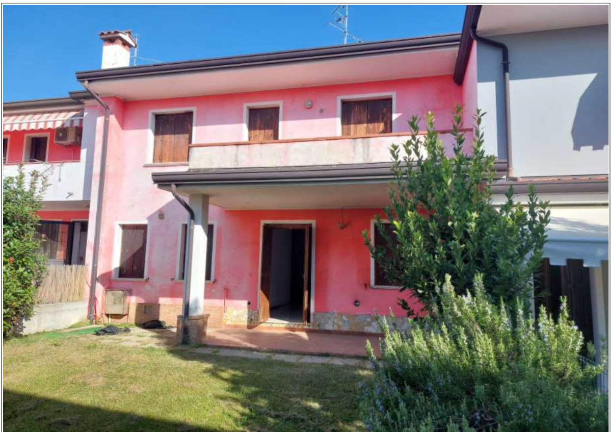
Foto n° 25 – 07/10/2023 - Comune di Sesto al Reghena, foglio 27, part.266, sub.3 – Retro dell'abitazione.
