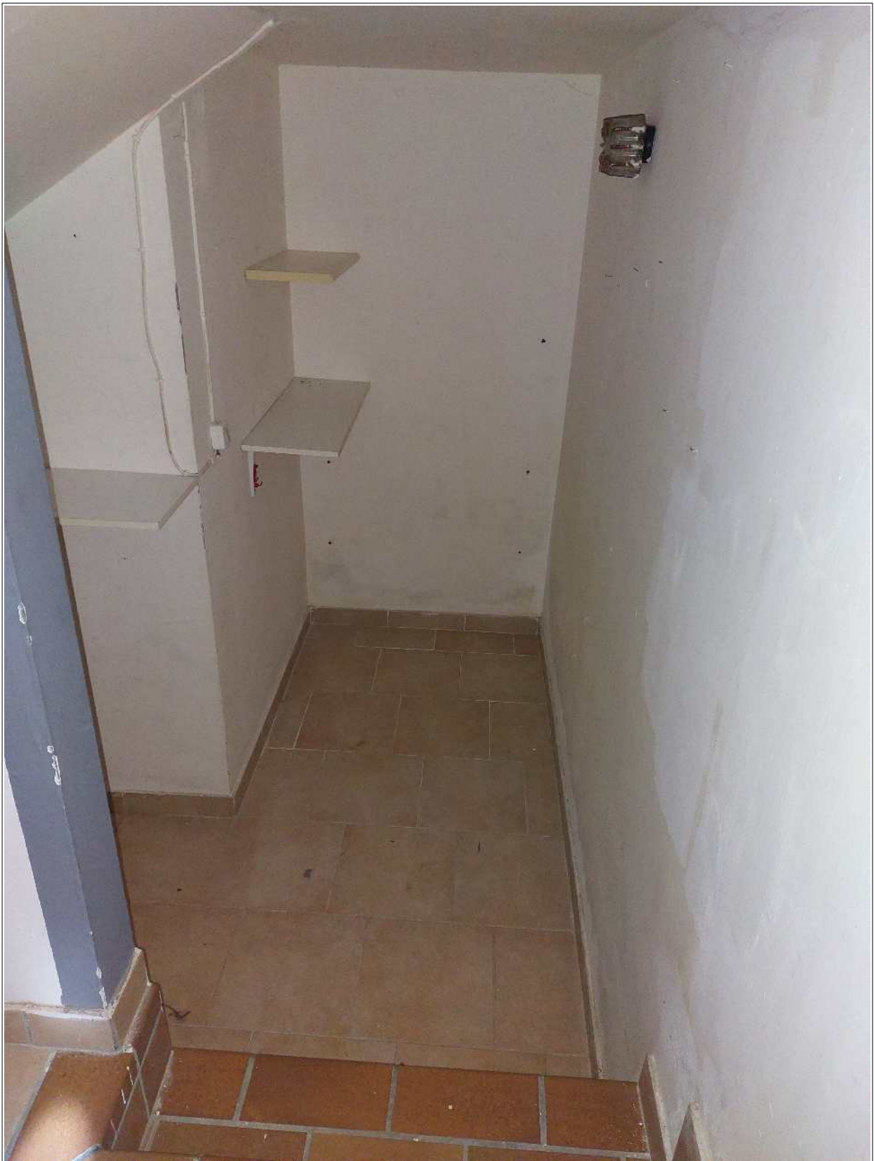
Foto n° 9 – 07/10/2023 - Comune di Sesto al Reghena, foglio 27, part.266, sub.1 – Ripostiglio.
