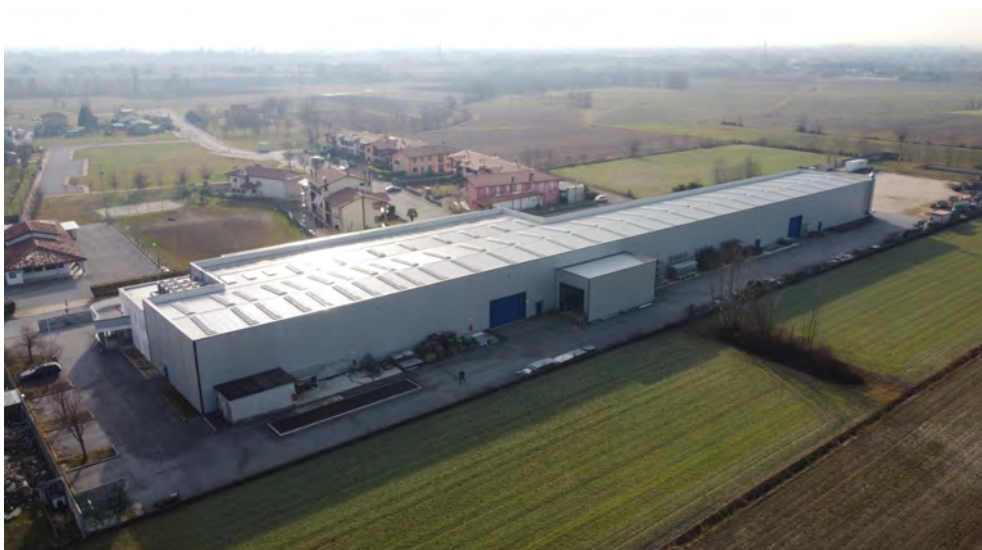
5. Foto: foto stabilimento lato ovest (drone)
