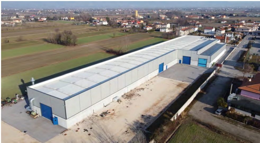
4. Foto: foto stabilimento lato sud-est (drone)
