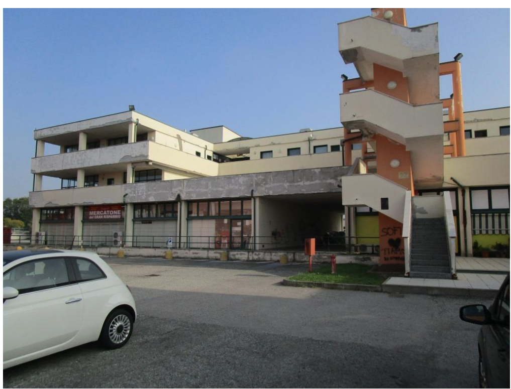
Foto 1 – Vista del complesso immobiliare
