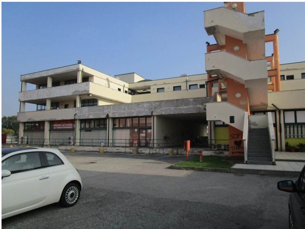
Foto 1 – Vista del complesso immobiliare
