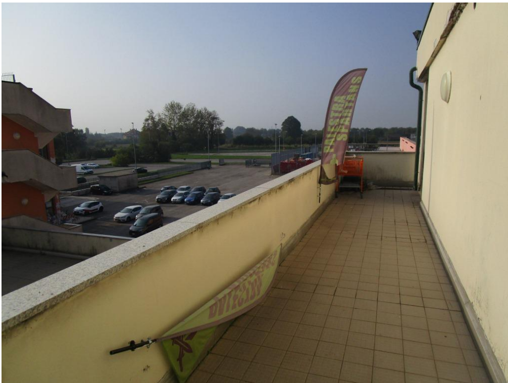
Foto 20 – Balcone (porzione sub 746)
