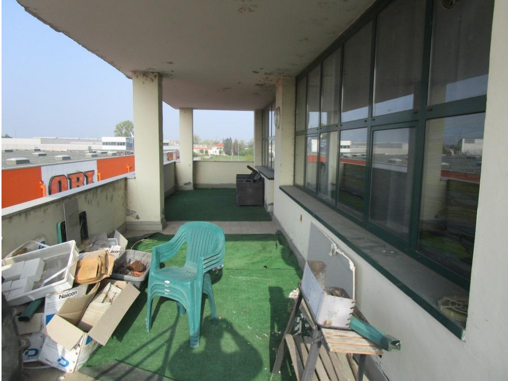
Foto 19 – Balcone con ingresso (porzione sub 746)
