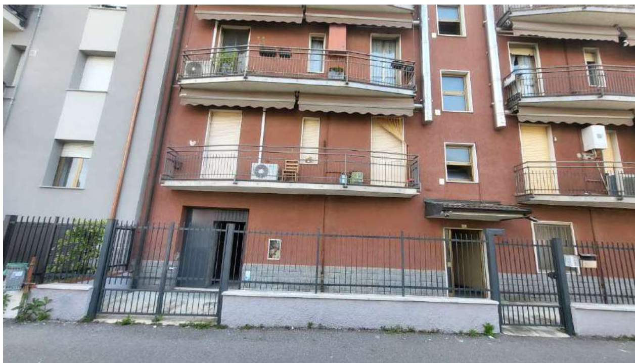
Cancelli di ingresso carraio e pedonale
