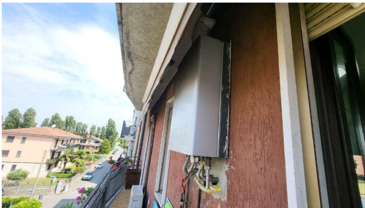
Dettagli – Caldaia murale autonoma a gas metano
