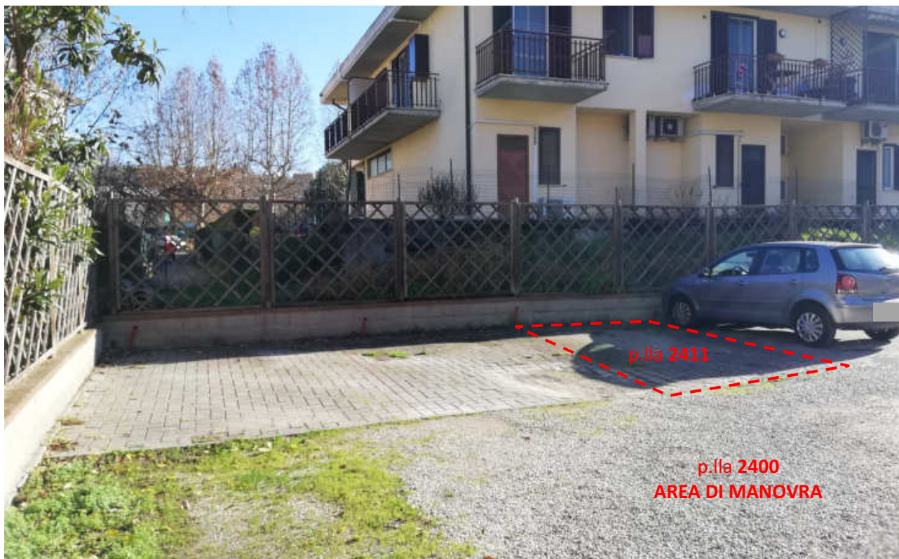
10) ESTERNI: evidenziata in rosso la particella n. 2411
