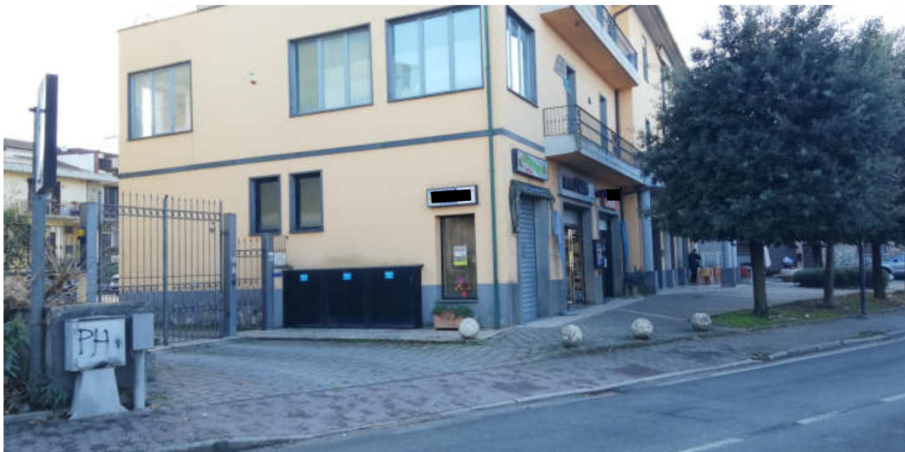
3) ESTERNI: vista all'angolo con accesso al civico n. 64/bis
