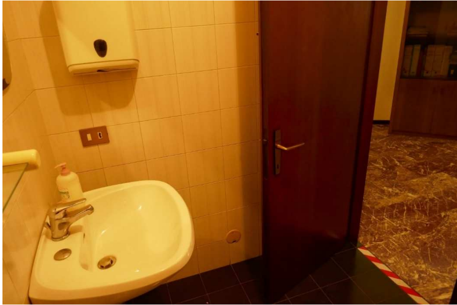
FOTO E.I. 85/2023 – VIA SAN GIULIANO 2 - PORDENONE
