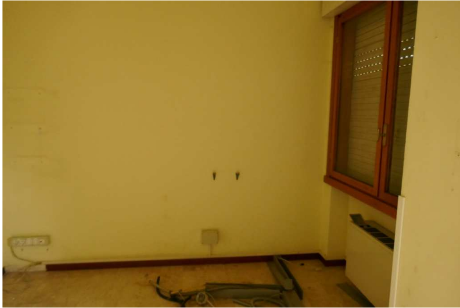
FOTO E.I. 85/2023 – VIA SAN GIULIANO 2 - PORDENONE
