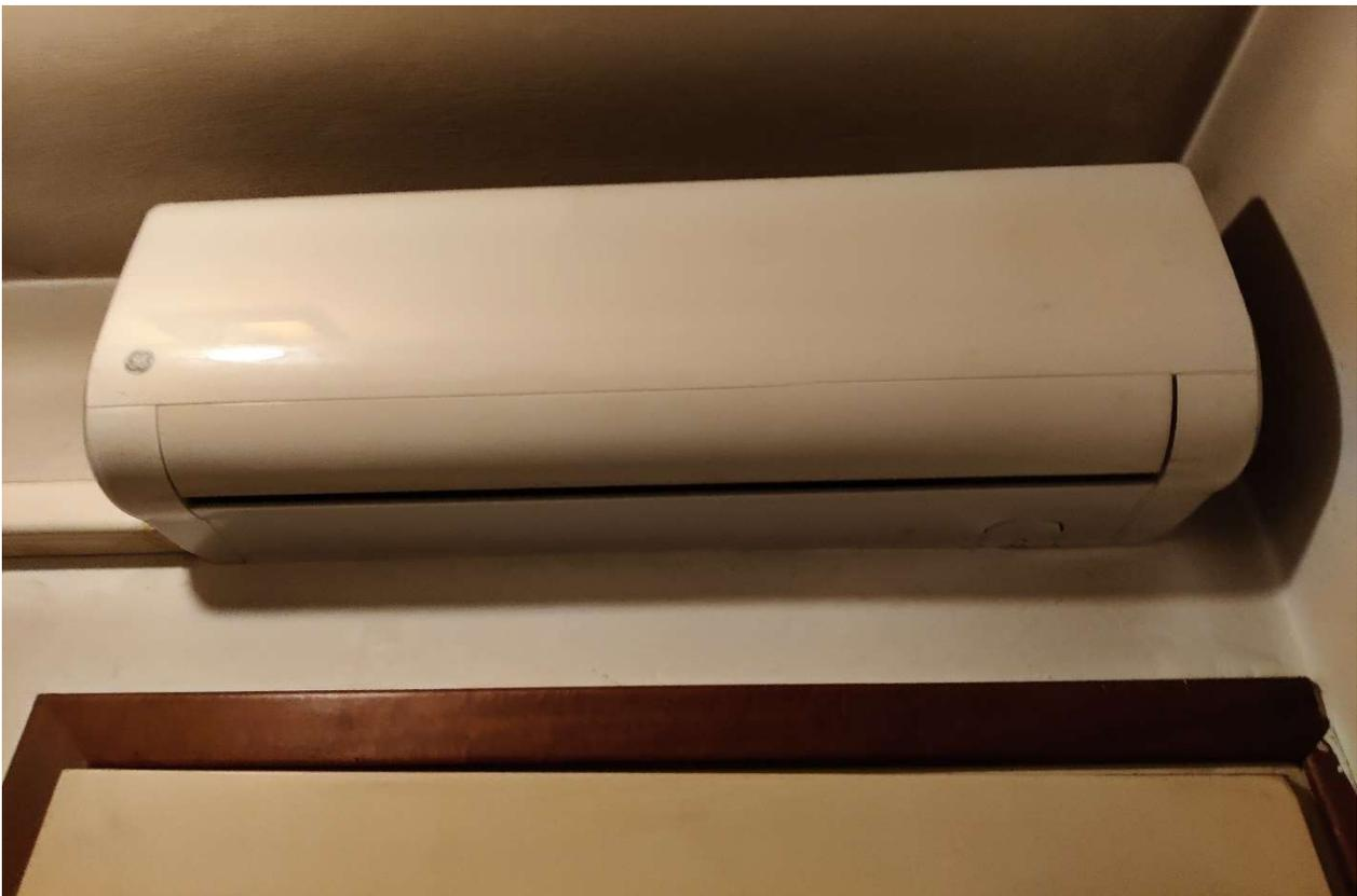
Foto n. 18 – Unità interna del condizionatore installato nel disimpegno al piano terra.
