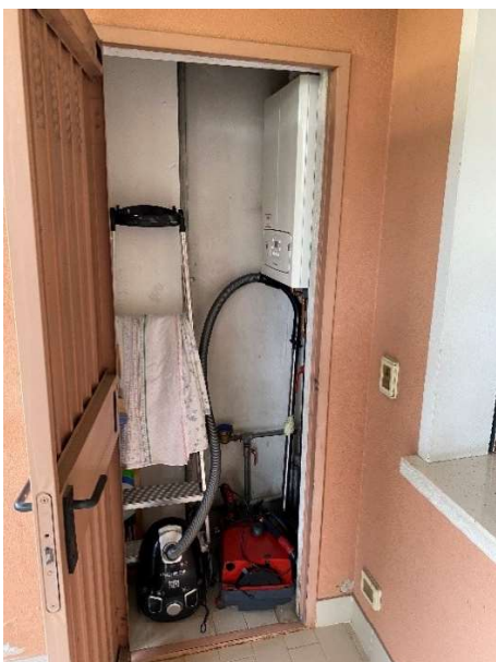
vista locale caldaia
