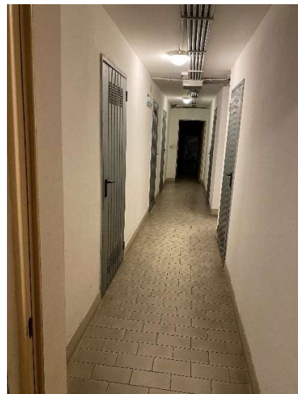
vista corridoio condominiale -sub. 75-
