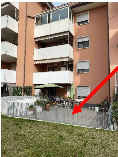
ulteriore vista corte esclusiva -sub. 79- terrazza
