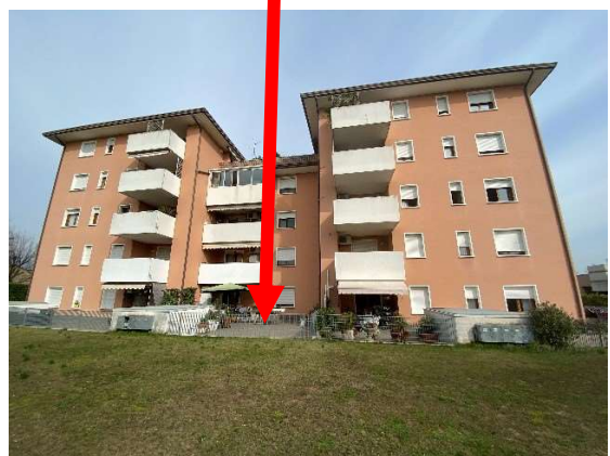
vista esterna condominio retro fabbricato
