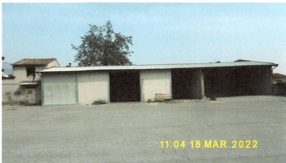
VISTA SUD-EST MAGAZZINI
