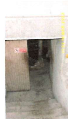
SCALA DA PIANO INTERRATO A TERRA
