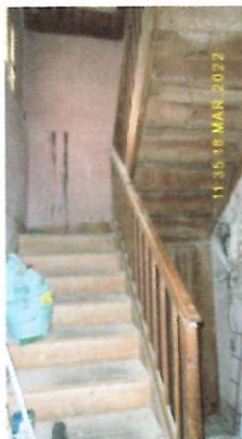
SCALA DA PIANO TERRA A PIANO PRIMO
