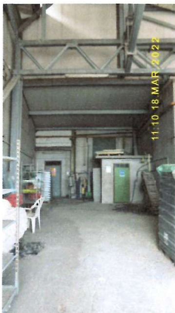
DEPOSITO E W.C.
