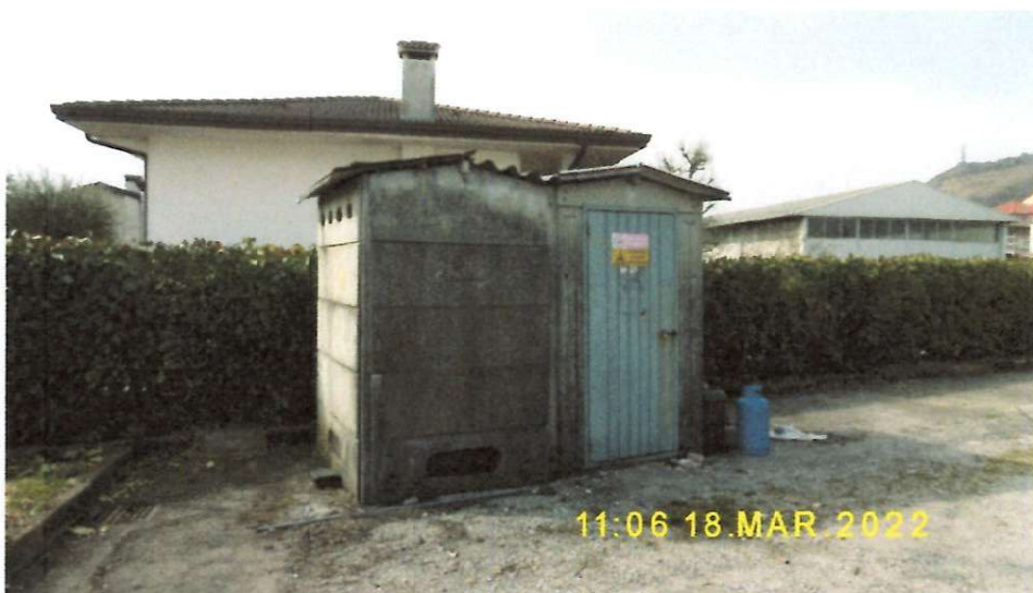
VISTA NORD-EST BOX PREFABBRICATO
