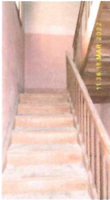
SCALA DA PIANO PRIMO A PIANO SECONDO
