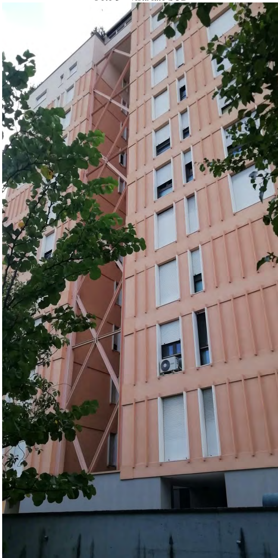
Foto 3 – vista lato SUD
