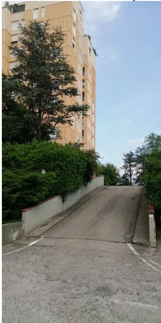
Foto 5 – vista lato NORD/OVEST rampa di accesso
