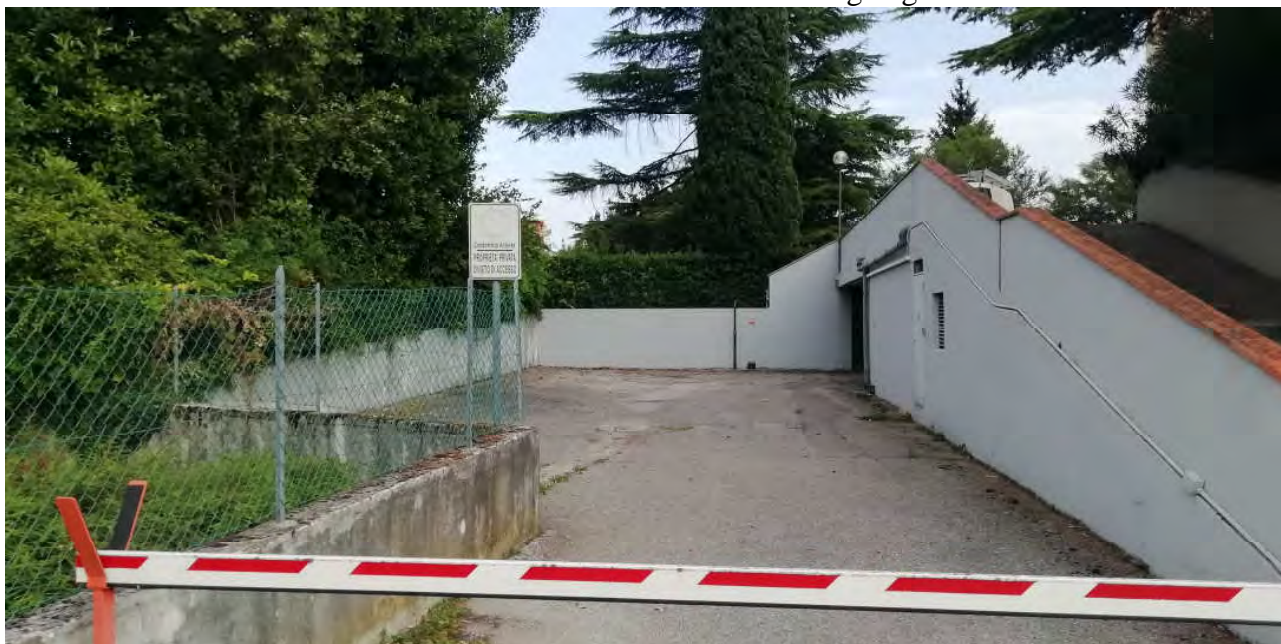
Foto 6 – vista lato NORD/EST uscita garage
