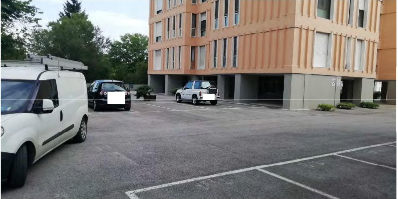
Foto 4 – vista lato NORD/EST piano terra
