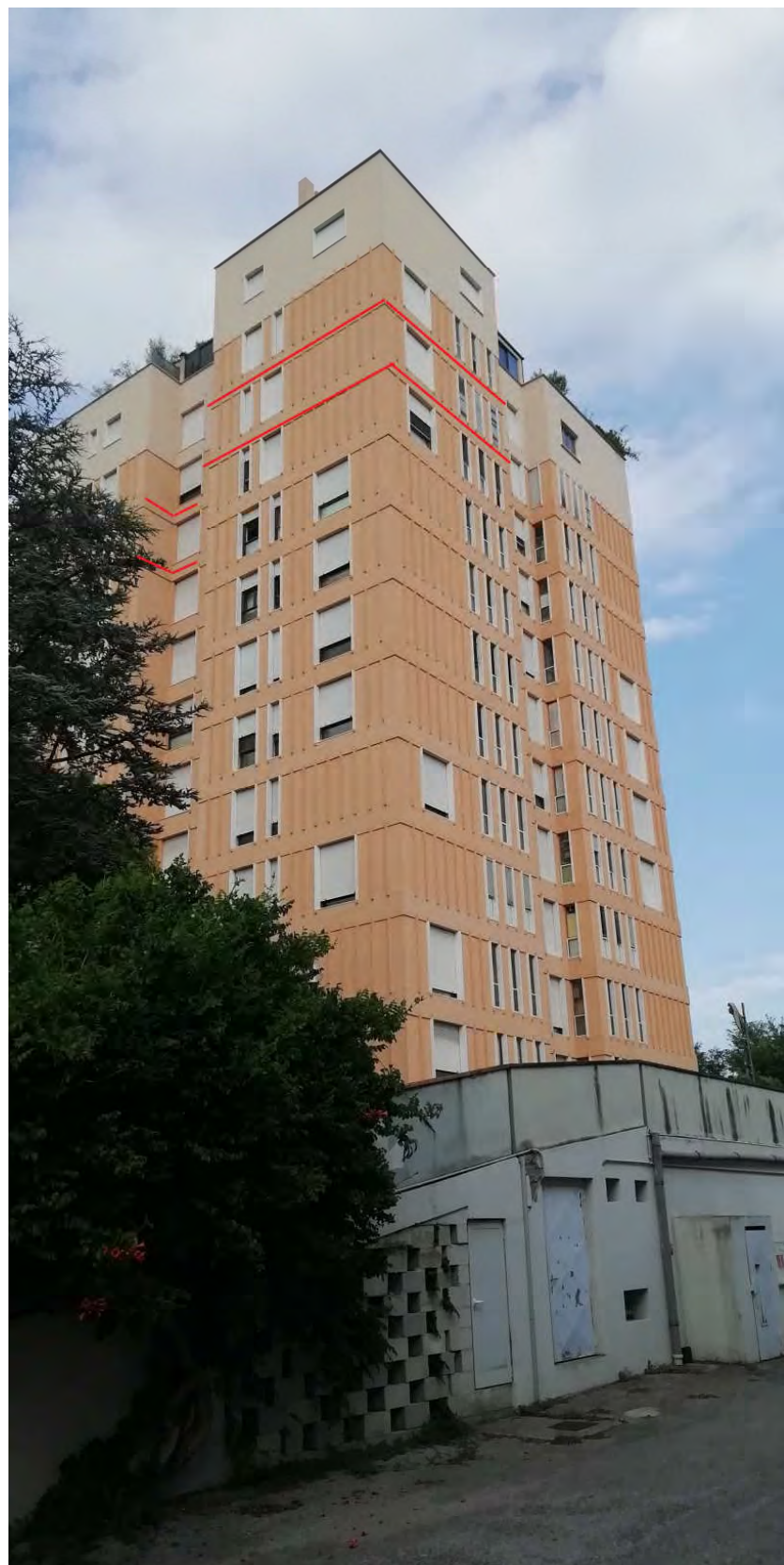
Foto 2 – vista lato NORD/EST
