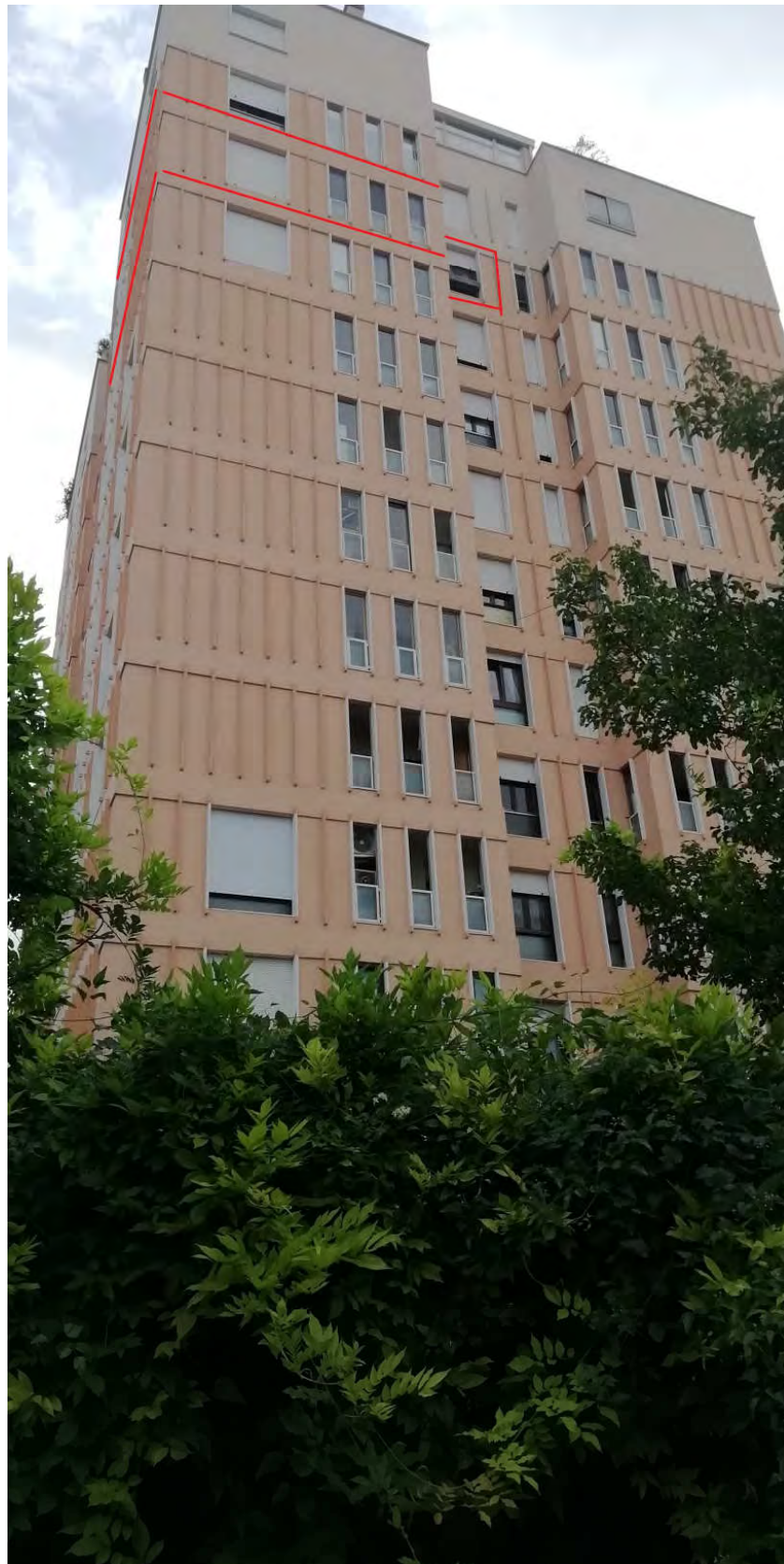
Foto 1 – vista lato NORD
