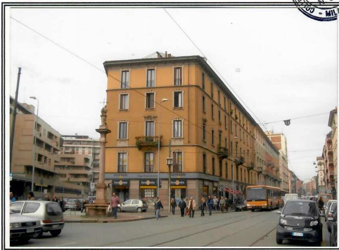
ESTERNO FABBRICATO – PROSPETTO SU PIAZZA DE ANGELI
