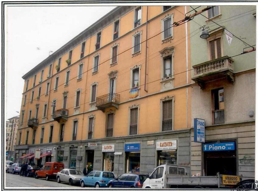
ESTERNO FABBRICATO – PROSPETTO SU VIA PARMIGIANINA
