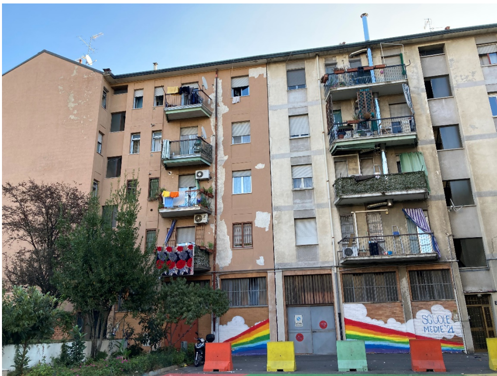
Foto n. 2: Prospetto principale su Piazza Garibaldi
