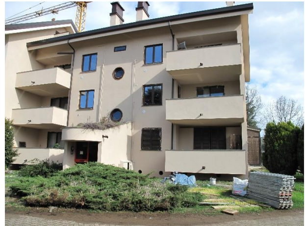
esterno edificio "B"
