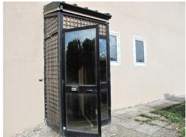
esterno edificio "B" – zona ingresso abitazione
