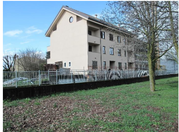
esterno edificio "B"
