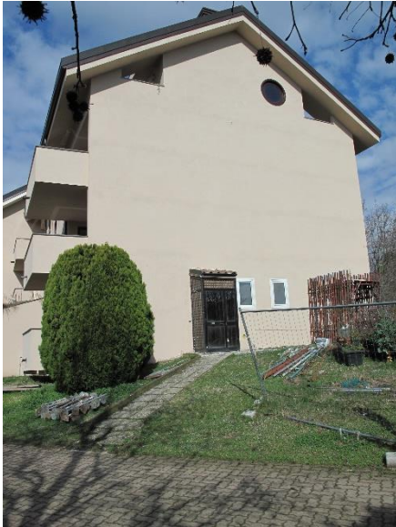
esterno edificio "B"
