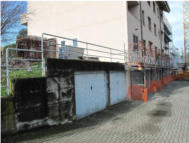
esterno edificio "B"
