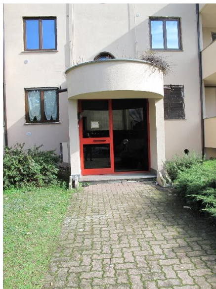
esterno edificio "B"
