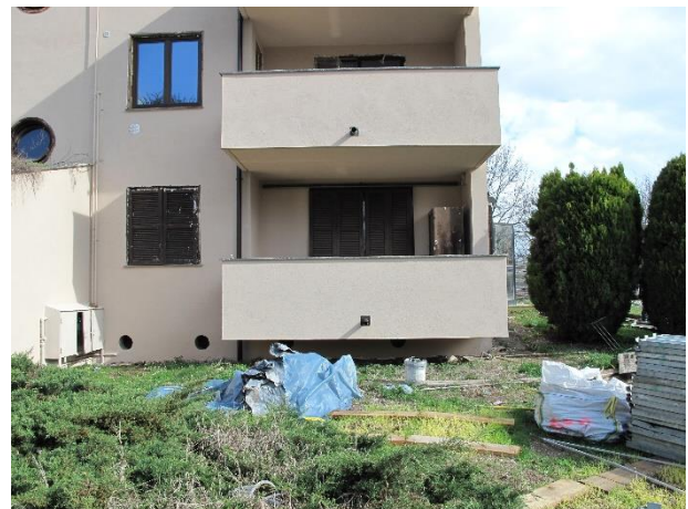
esterno edificio "B"
