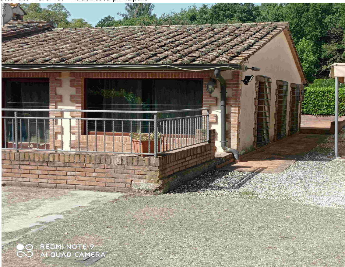
Prospetto lato Nord-Est – Fabbricato principale
