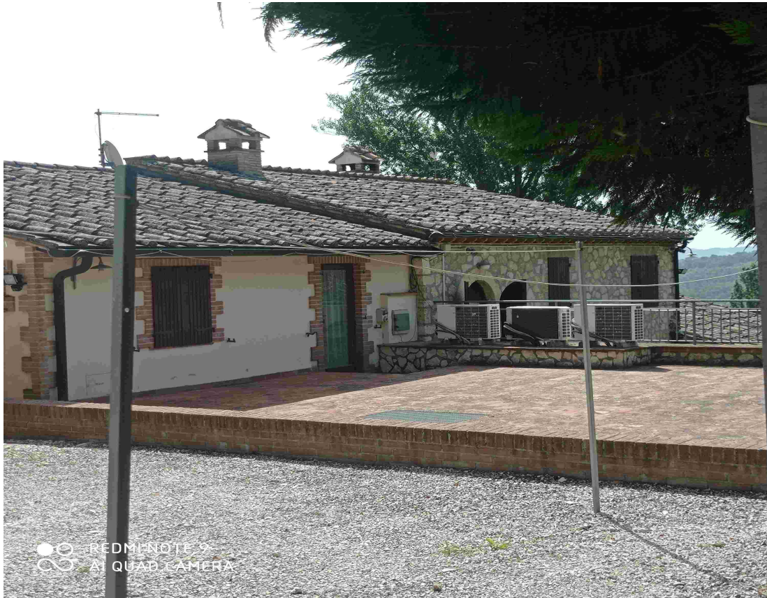
Prospetto lato Nord- Ovest – Fabbricato principale
