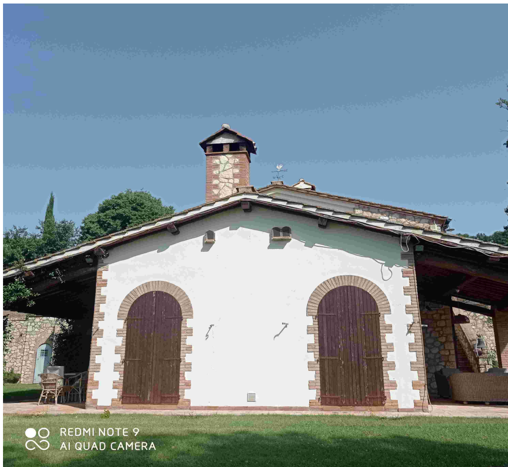
Prospetto lato Sud – Fabbricato principale
