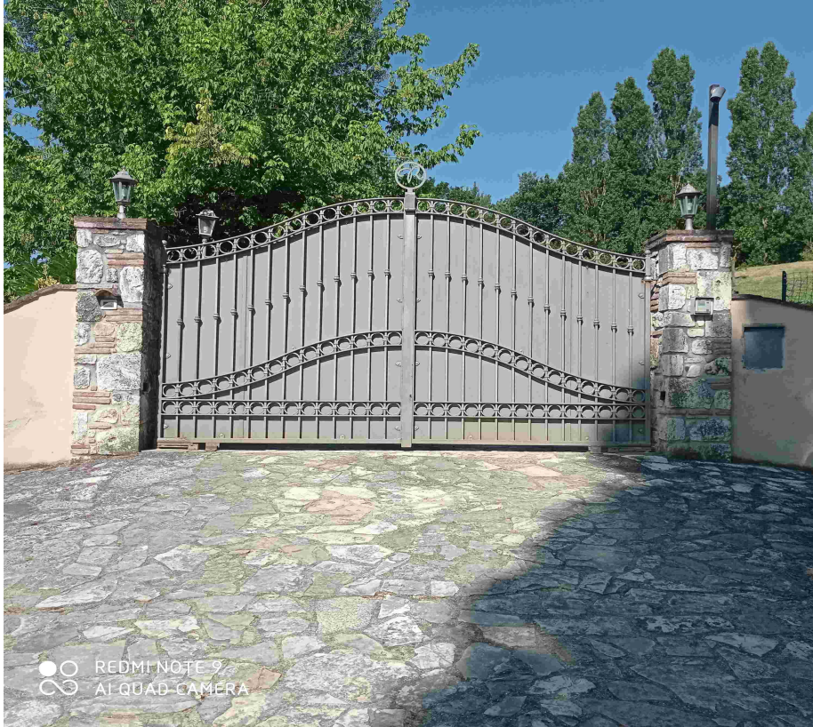
Particolare cancello d'ingresso principale su strada Provinciale Via Ortana - lato Sud
