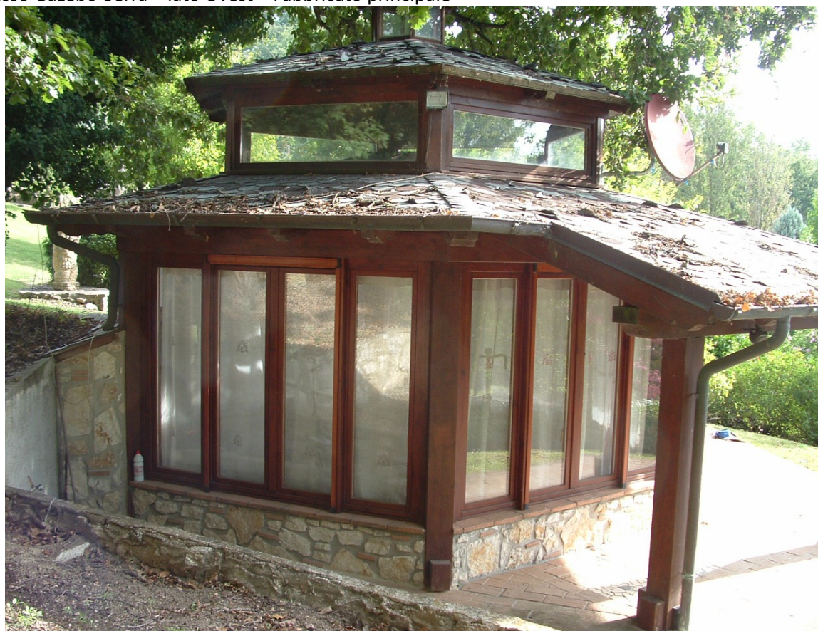
Annesso Gazebo-Serra – lato Ovest – Fabbricato principale
