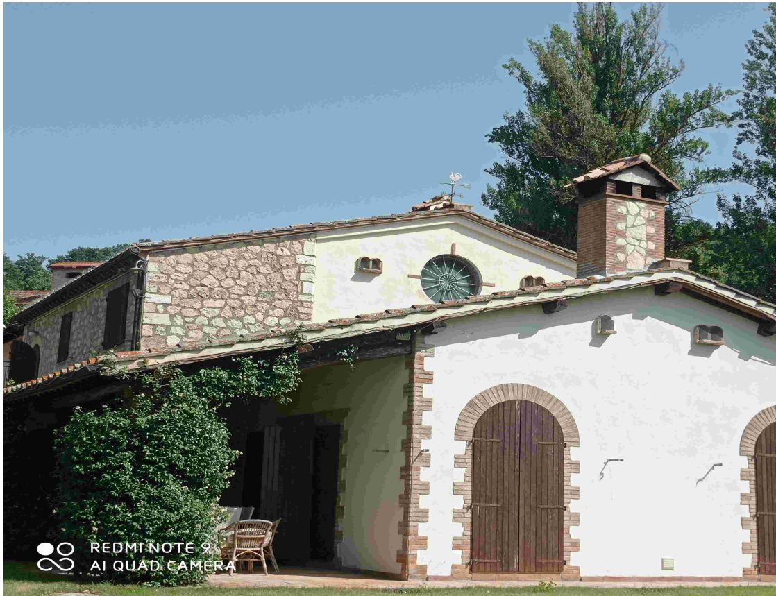
Prospetto lato Sud-Ovest – Fabbricato principale
