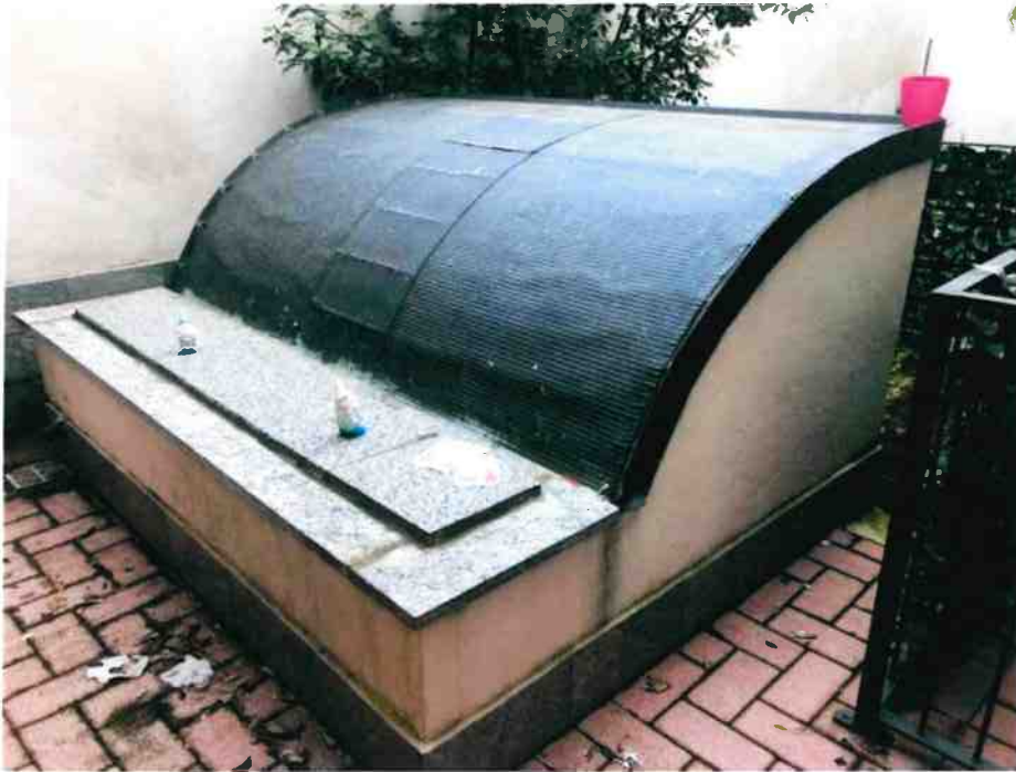
Dettaglio lucernario nel giardino di pertinenza
