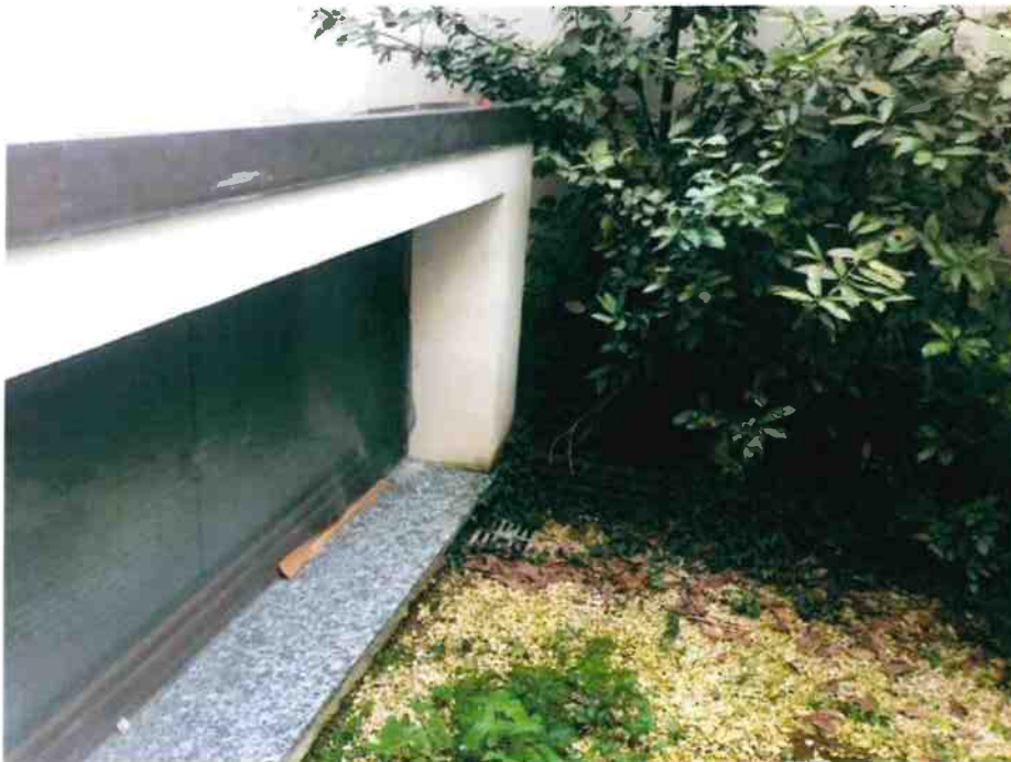
Dettaglio struttura lucernario aerazione illuminazione camera (taverna) al piano int.
