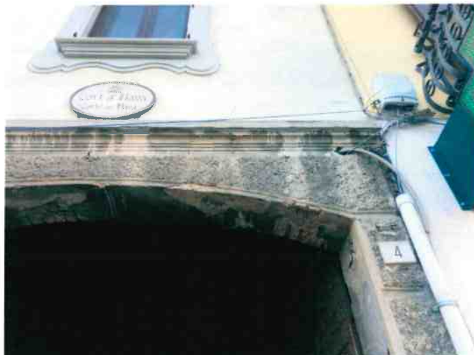
All'unità immobiliare si accede dall'ingresso del fabbricato civ. 4
