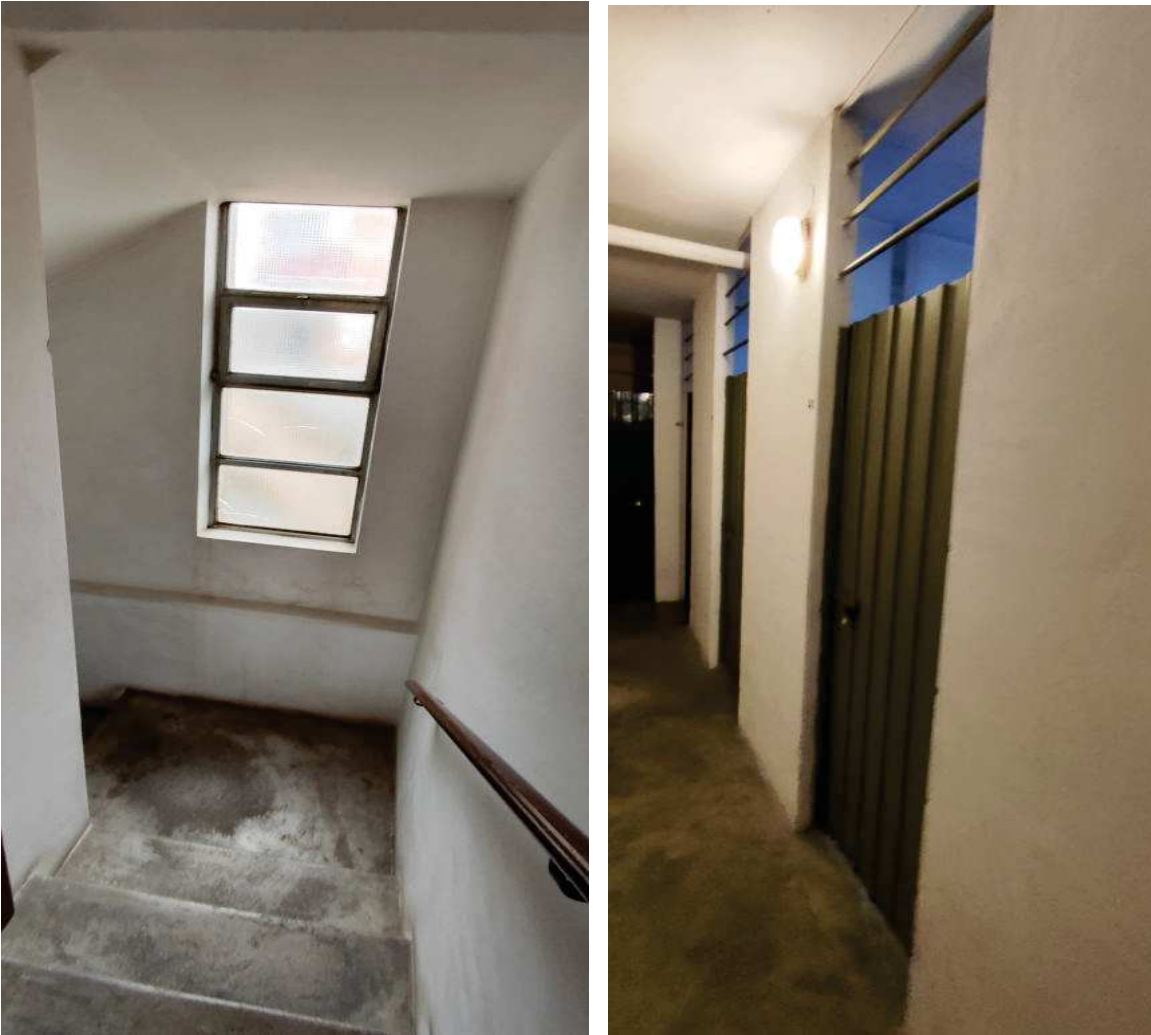
FOTO N.22 FOGLIO 31, MAPPALE 206 SUB.41 VIA SEGALUZZA 8 PORDENONE (PN)
