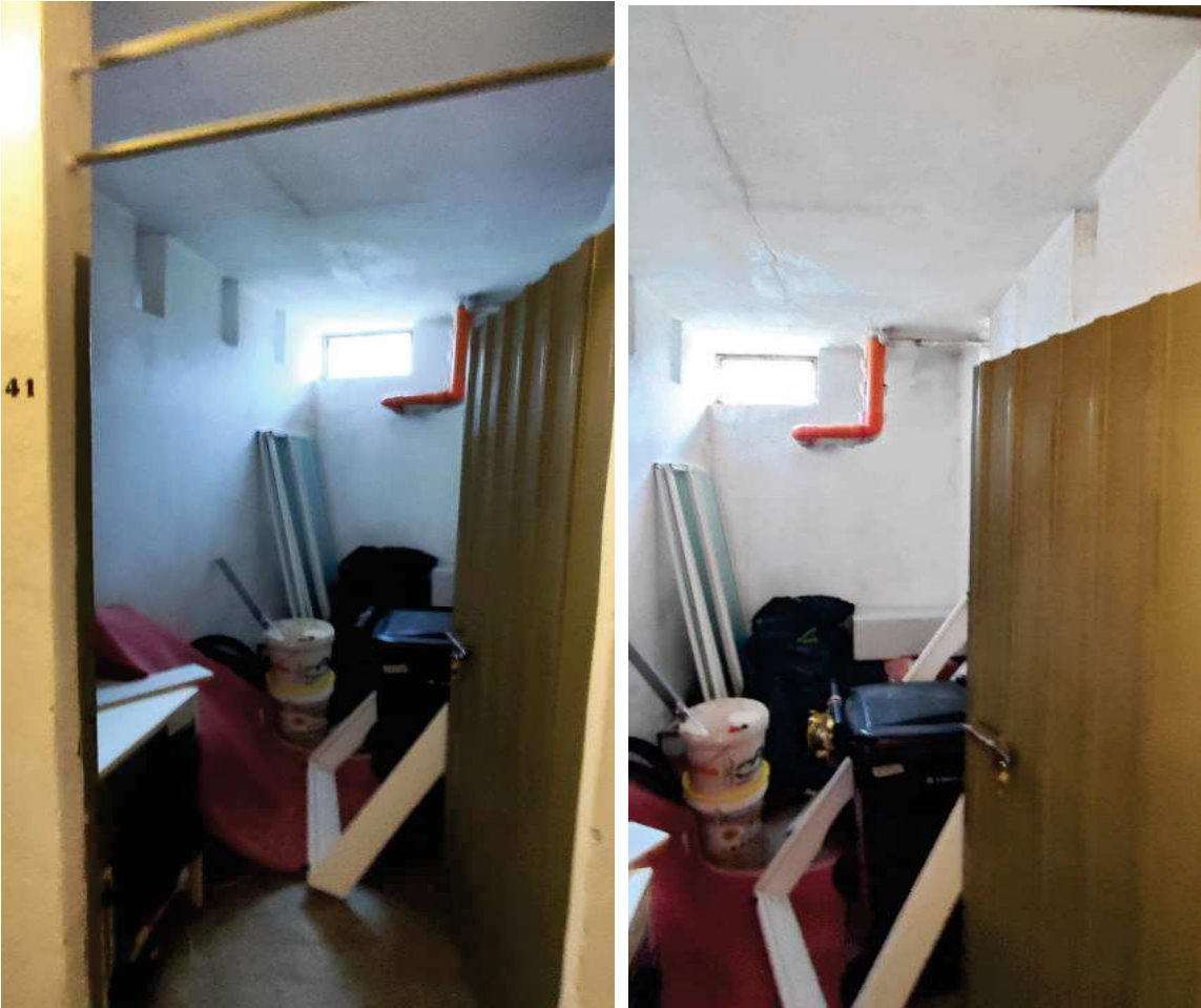
FOTO N.27 FOGLIO 31, MAPPALE 206 SUB.41 VIA SEGALUZZA 8 PORDENONE (PN)
