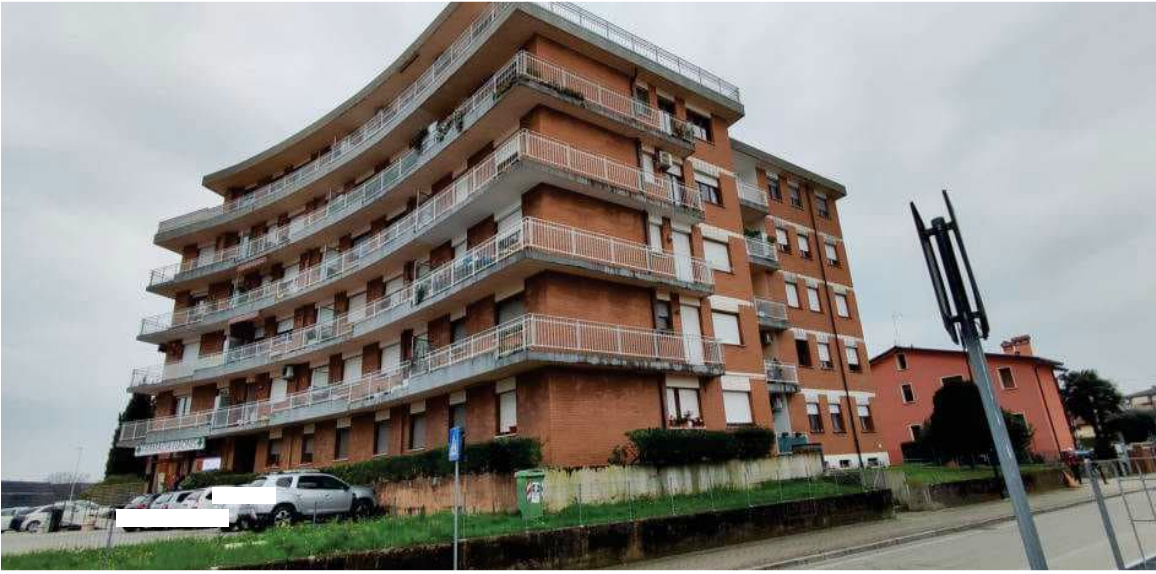
FOTO N.02 FOGLIO 31, MAPPALE 206 SUB.41 VIA SEGALUZZA 8 PORDENONE (PN)
