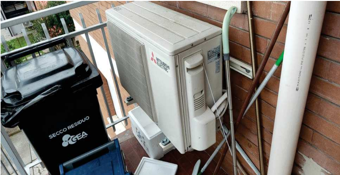
FOTO N.19 FOGLIO 31, MAPPALE 206 SUB.41 VIA SEGALUZZA 8 PORDENONE (PN)
