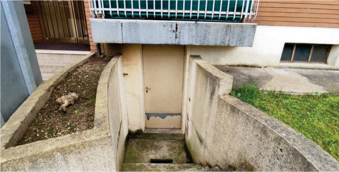
FOTO N.29 FOGLIO 31, MAPPALE 206 SUB.41 VIA SEGALUZZA 8 PORDENONE (PN)
