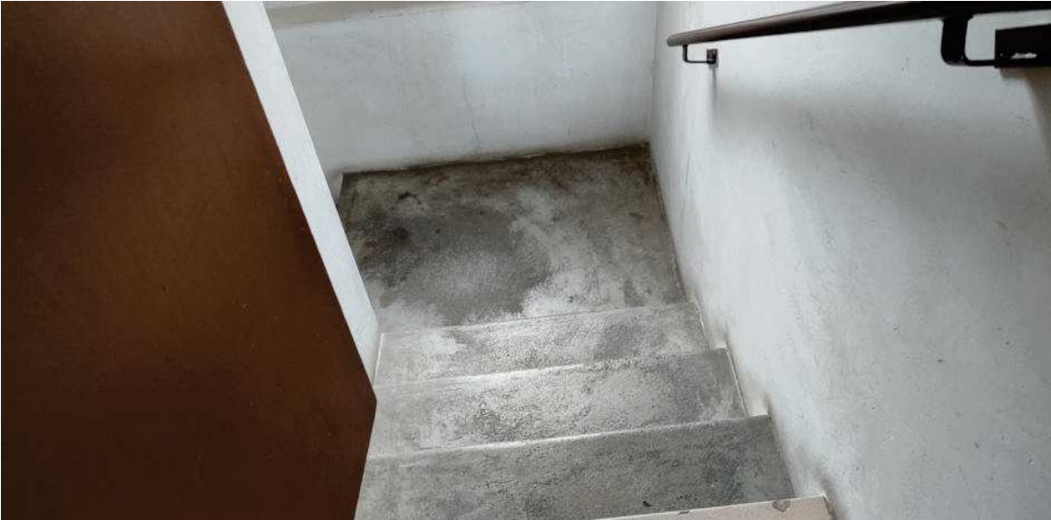
FOTO N.21 FOGLIO 31, MAPPALE 206 SUB.41 VIA SEGALUZZA 8 PORDENONE (PN)
