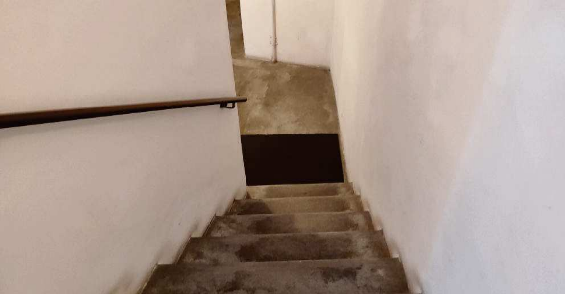
FOTO N.24 FOGLIO 31, MAPPALE 206 SUB.41 VIA SEGALUZZA 8 PORDENONE (PN)
