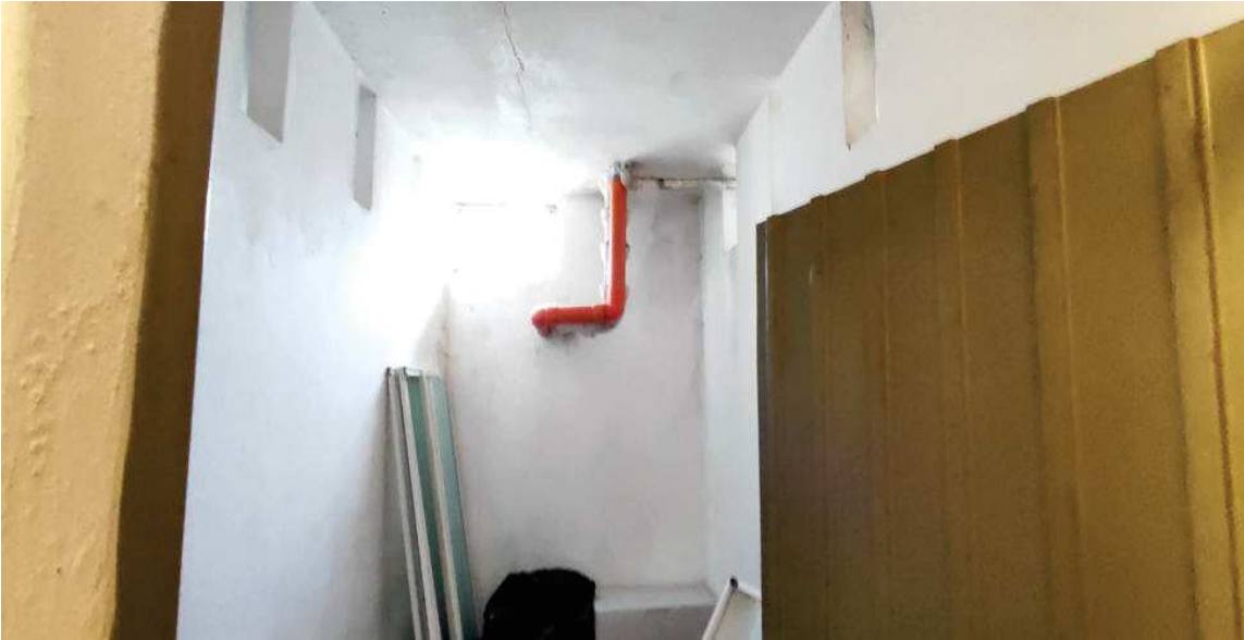
FOTO N.26 FOGLIO 31, MAPPALE 206 SUB.41 VIA SEGALUZZA 8 PORDENONE (PN)
