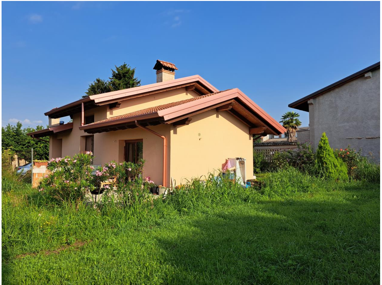
Foto n° 3 - Lotto 2 - 17/07/2023 – Comune di Pinzano al Tagliamento (PN) – Località Valeriano - Foglio 12 m.li 2033 e 2082 – Veduta dell'abitazione e del giardino da posizione sud est.
