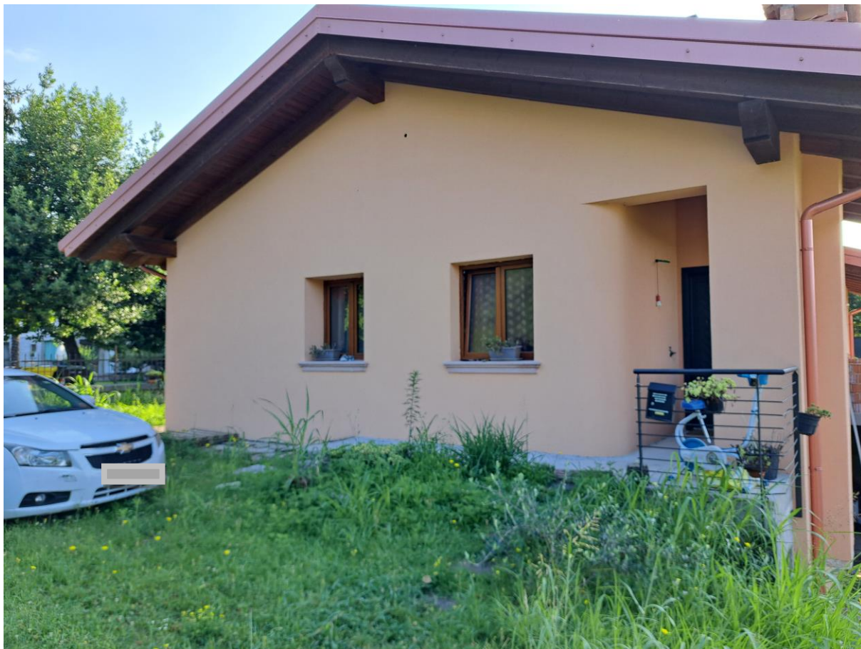
Foto n° 1 - Lotto 2 - 17/07/2023 – Comune di Pinzano al Tagliamento (PN) – Località Valeriano - Foglio 12 m.le 2033 sub 5 – Veduta esterna dell'abitazione di categoria A/7 dalla zona di accesso principale.
