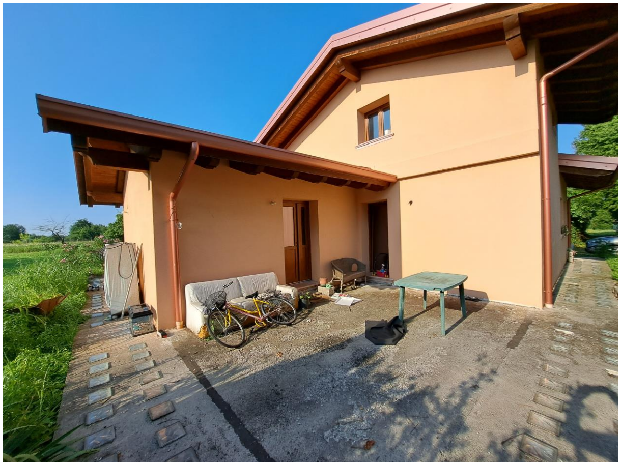
Foto n° 6 - Lotto 2 - 17/07/2023 – Comune di Pinzano al Tagliamento (PN) – Località Valeriano - Foglio 12 m.le 2033 sub 5 – Veduta della terrazza posta a nord rispetto al vano cucina pranzo.
