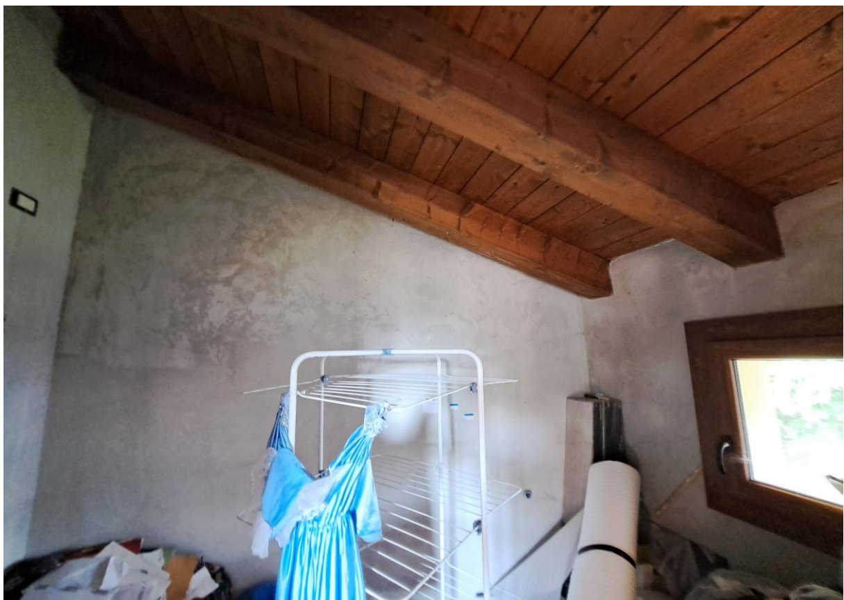
Foto n° 28 - Lotto 2 - Comune di Pinzano al Tagliamento (PN) - Località Valeriano - Foglio 12 m.le 2033 sub 5 - Primo piano: veduta interna del ripostiglio.
