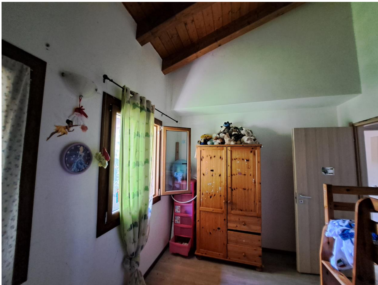
Foto n° 17 – Lotto 2 - Comune di Pinzano al Tagliamento (PN) – Località Valeriano - Foglio 12 m.le 2033 sub 5 – Piano terra: veduta della stessa camera da posizione ovest.
