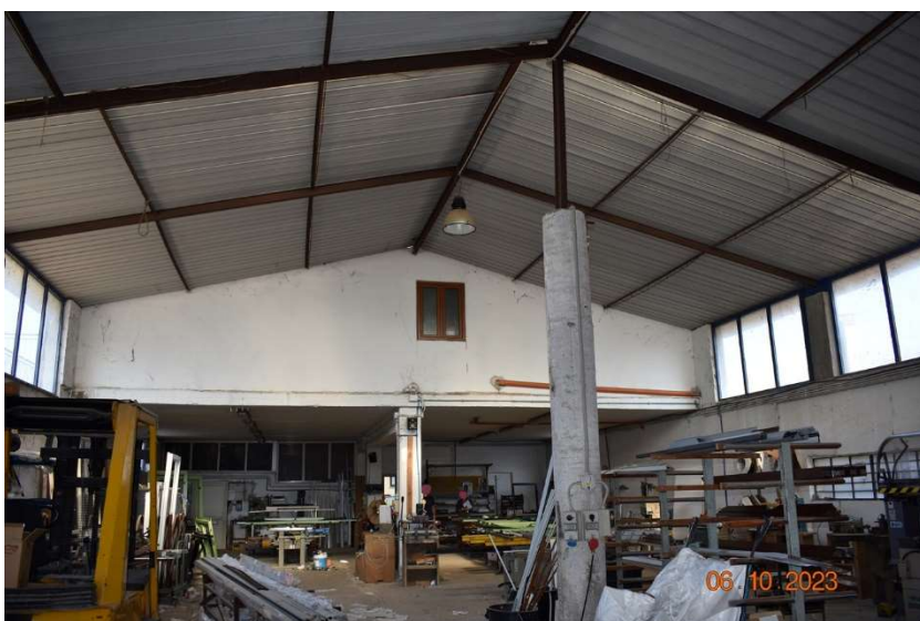
Foto 18 Vista ambiente interno lato ovest
