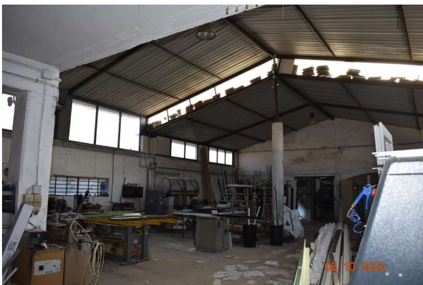
Foto 17 Vista ambiente interno lato ovest
