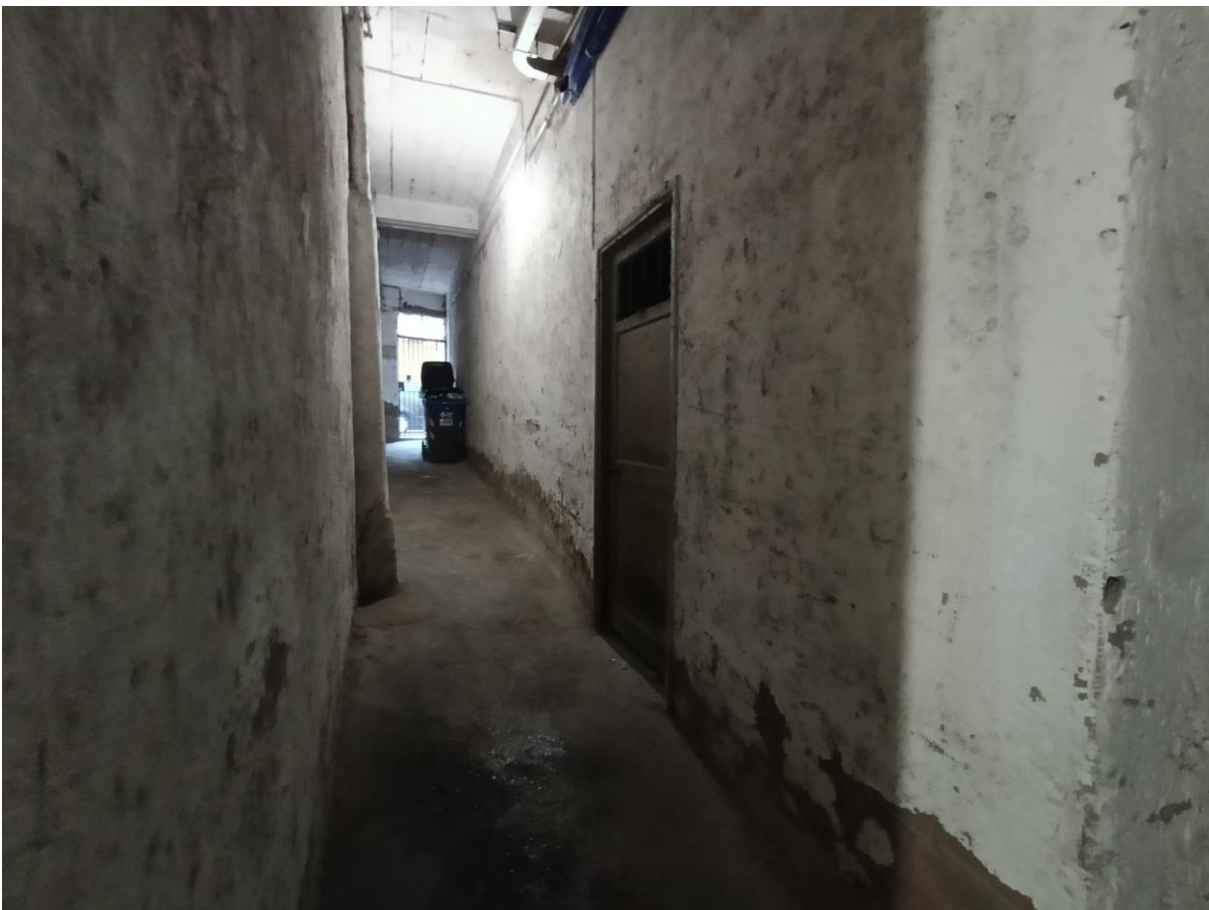
Cantina di pertinenza posta al piano seminterrato
