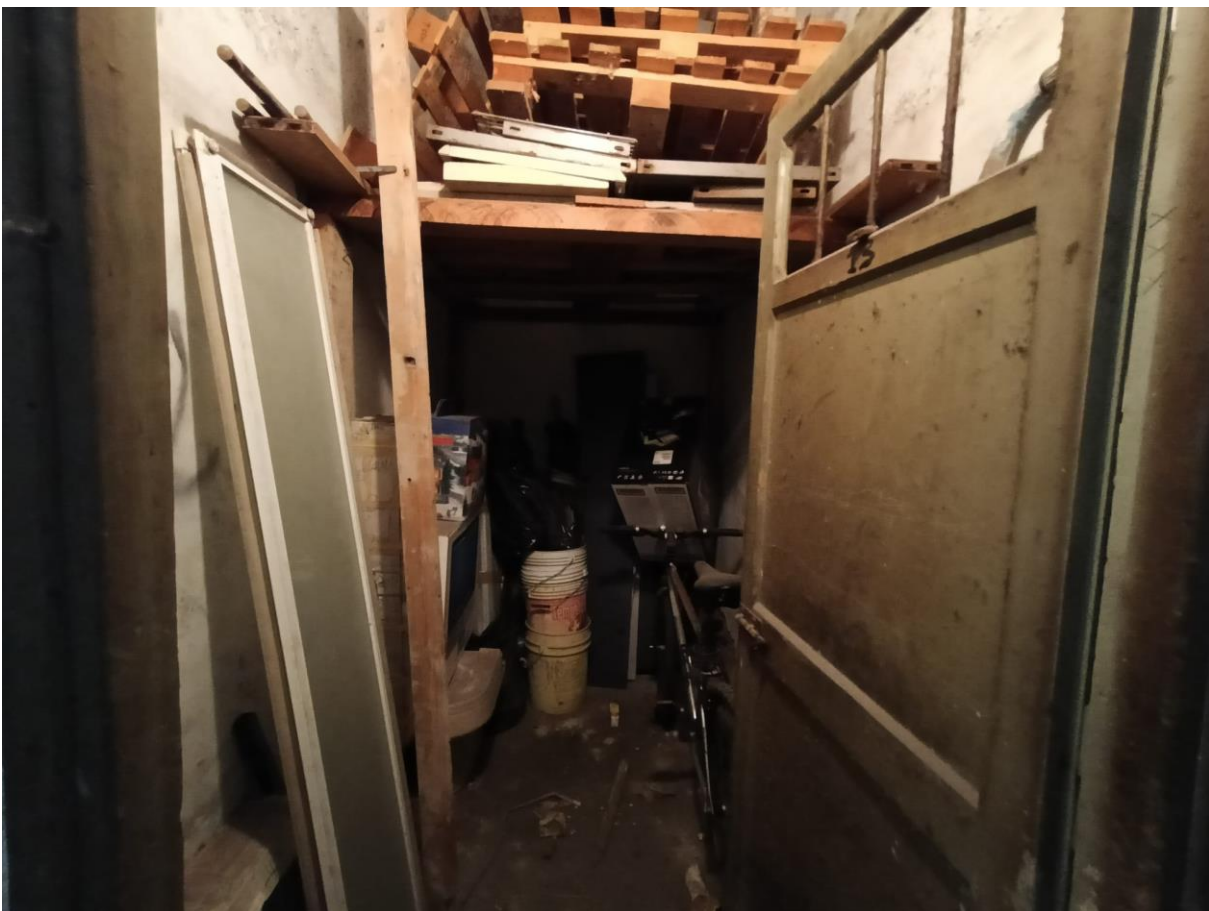
Cantina di pertinenza posta al piano seminterrato
