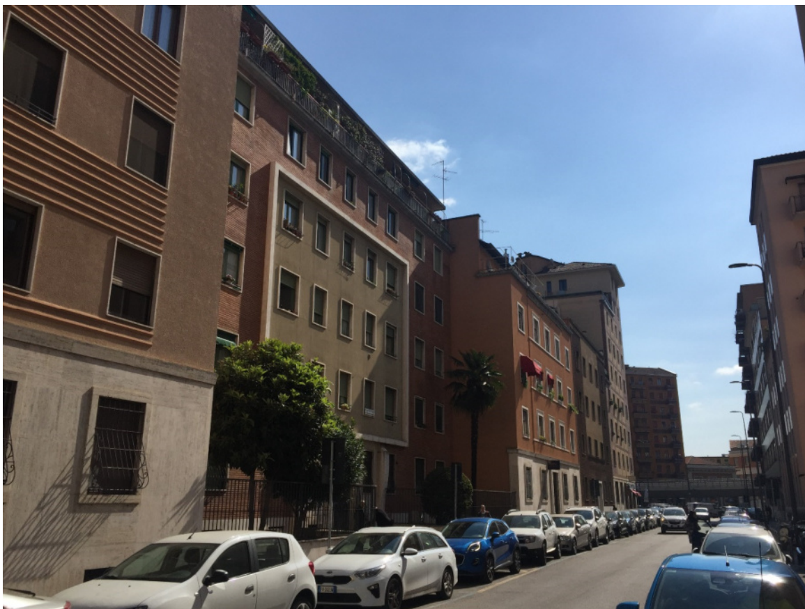
Foto 01 - Il fabbricato su via privata Antonelli
