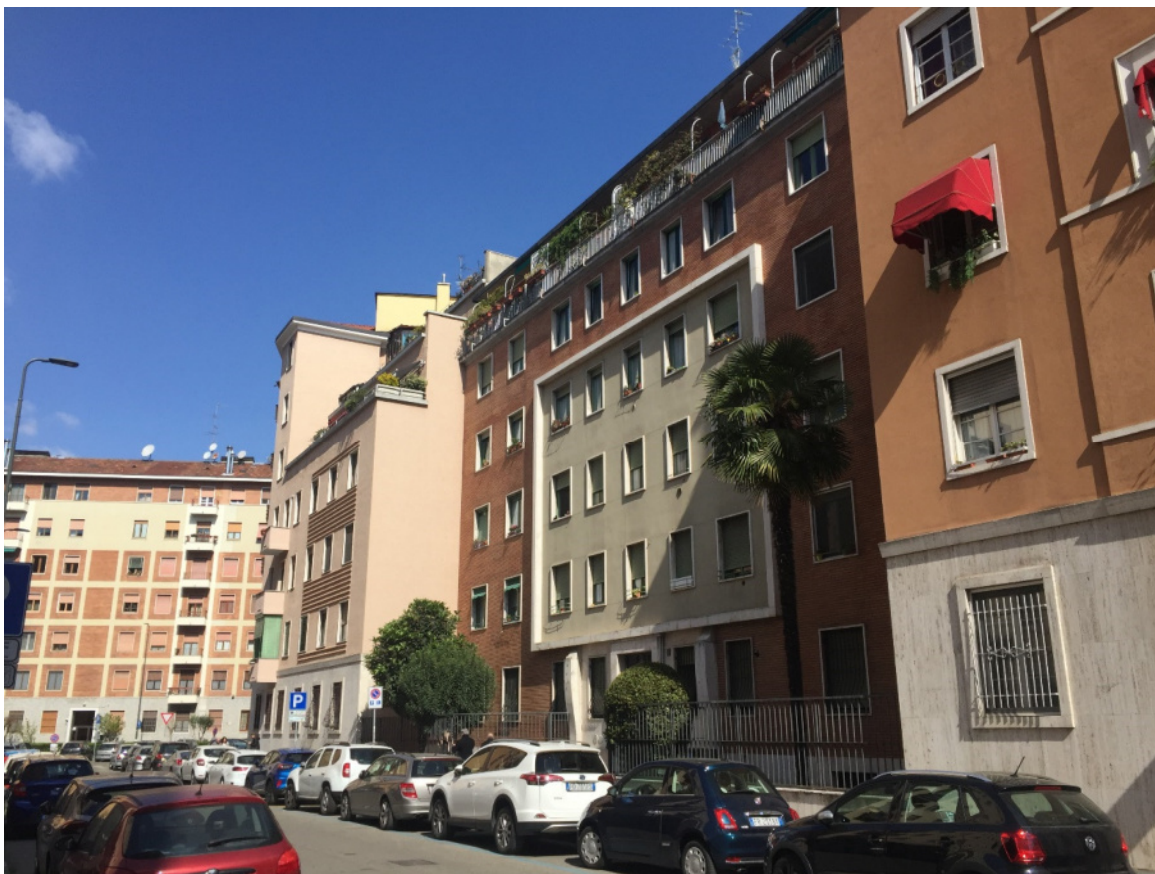
Foto 02 - Il fabbricato su via privata Antonelli
