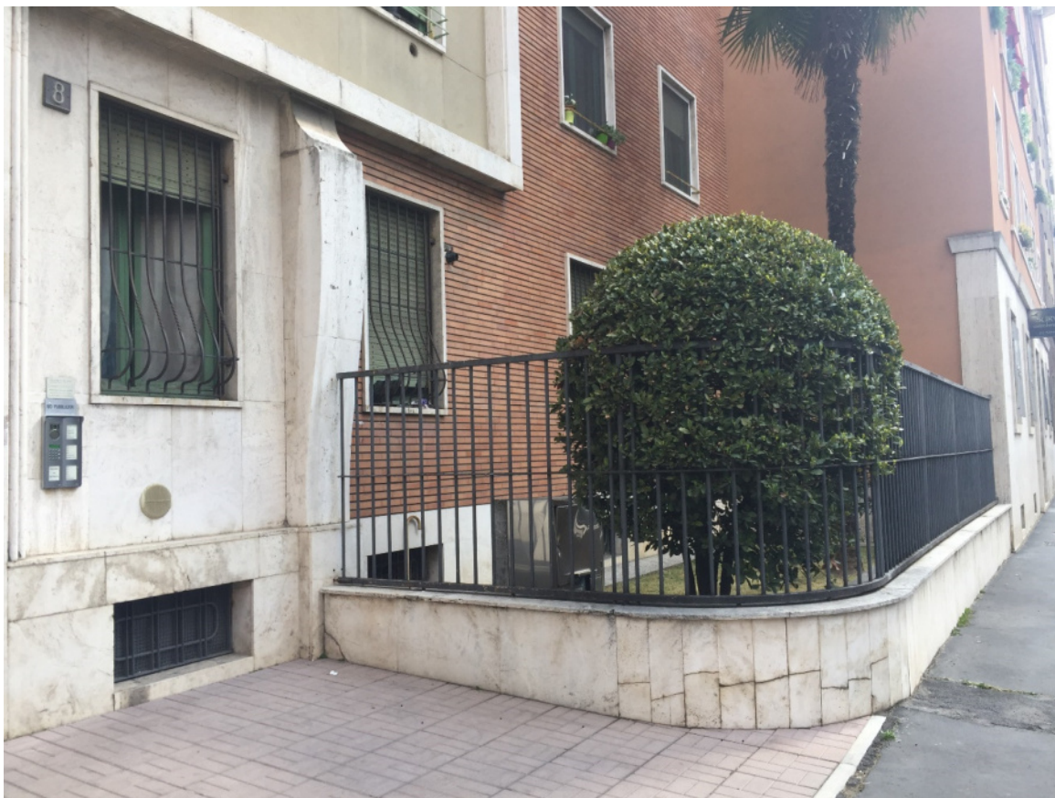
Foto 03 - Facciata del fabbricato in corrispondenza dell'unità
