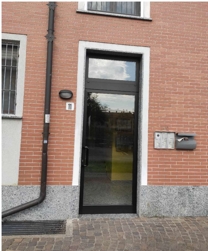
Foto n. 2 – Ingresso al fabbricato
