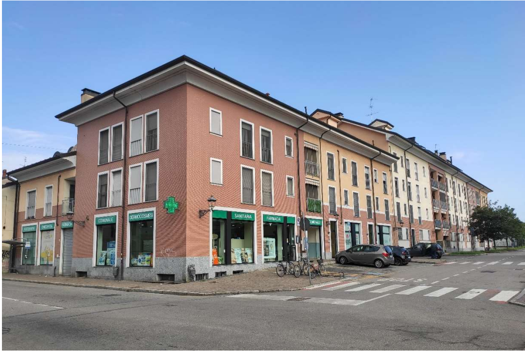
Foto n. 1 – Prospetto del fabbricato
