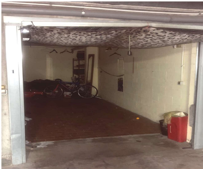
Foto D-Veduta interna del BOX
