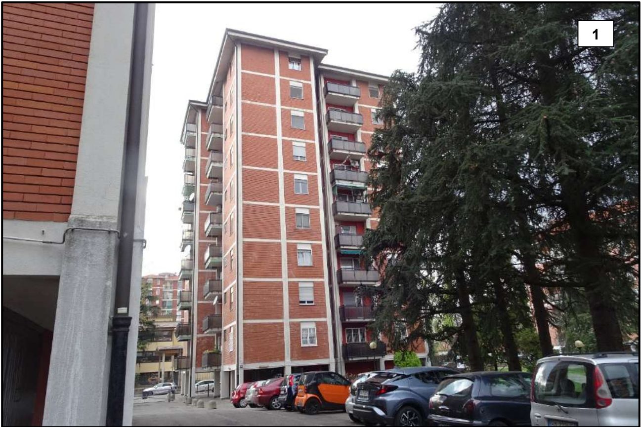
LOTTO A - VISTA GENERALE ESTERNA LATERALE EDIFICIO DA VIA SANTA TERESA
