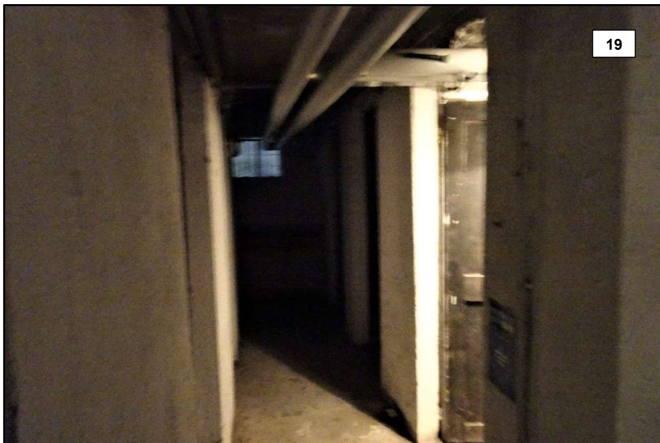
LOTTO A - CANTINA (vista esterna da corridoio comune)
