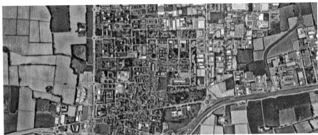
QUARTIERE SATELLITE VISTA DA ALTO
