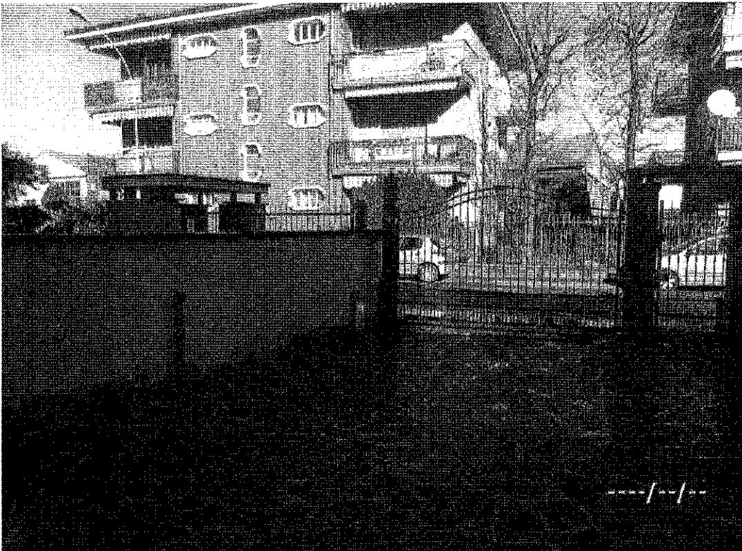
Foto n. 18: Ingresso carrabile da Via Sant'Ambrogio.
