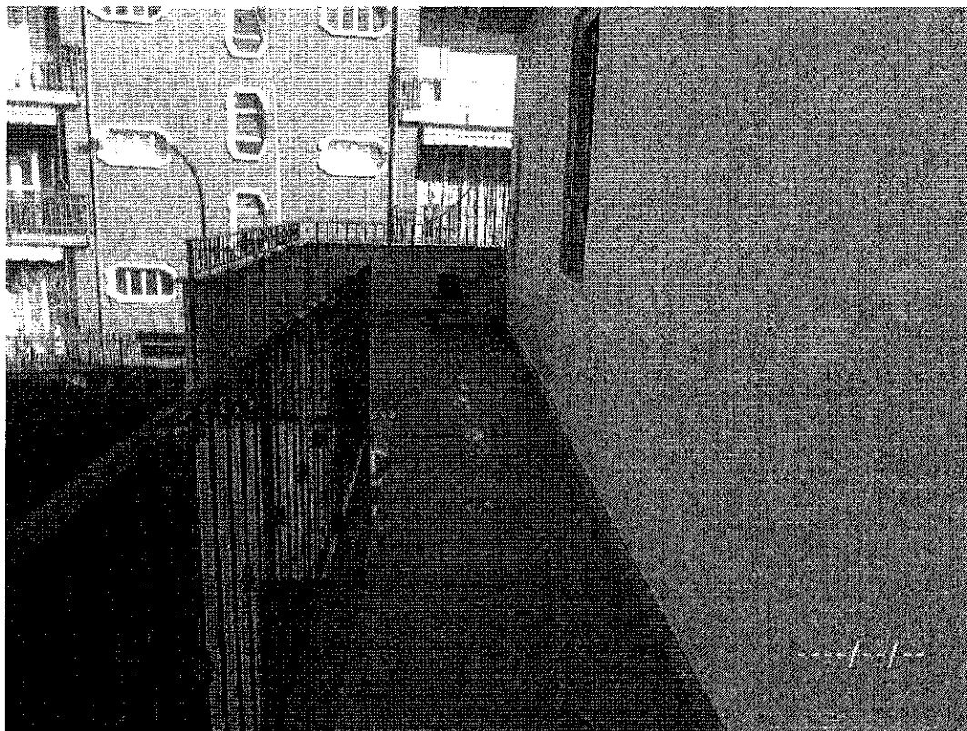
Foto n. 10: Terrazzo ad Ovest.
