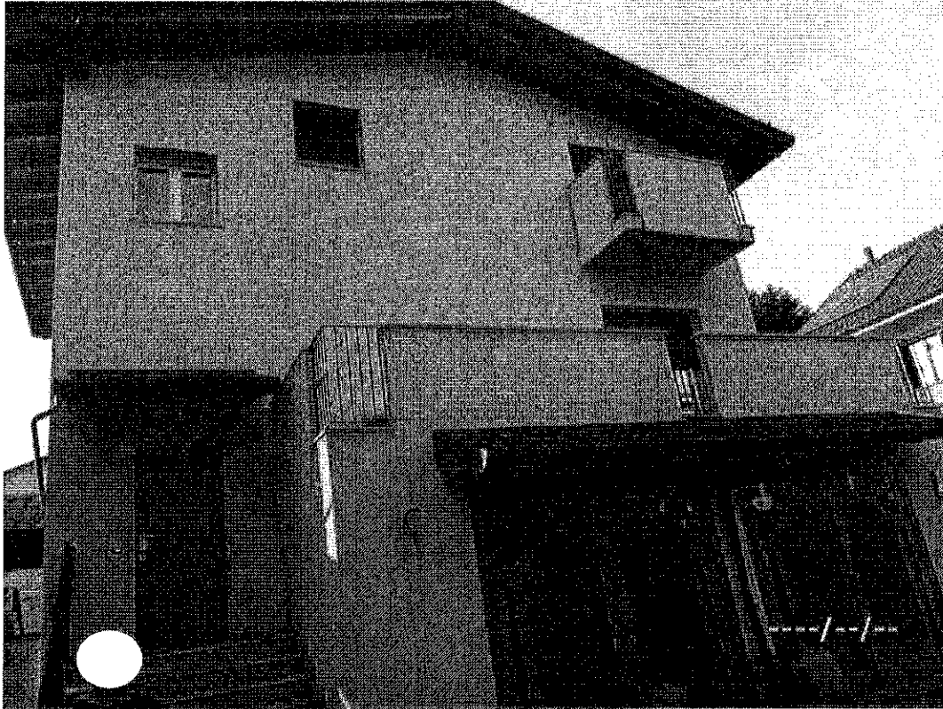
Foto n. 15: Vista prospetto principale.
