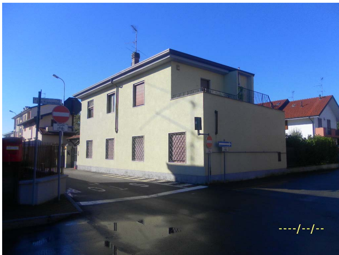
Foto n. 13: Prospetti Nord ed Est.
