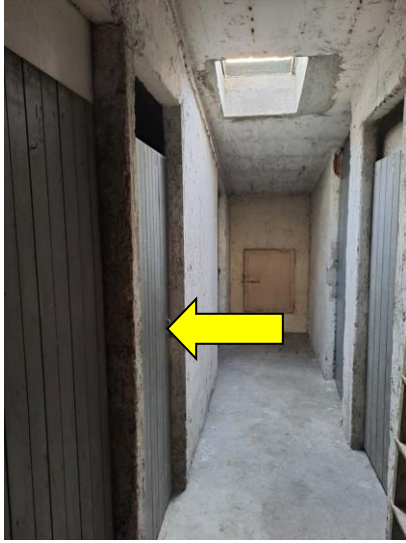
41. Solaio di pertinenza
