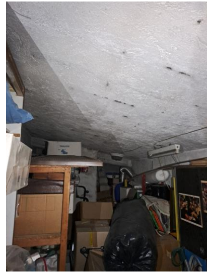
44. Interno del solaio
