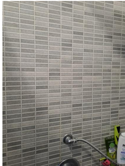
32. Rivestimento interno della doccia
