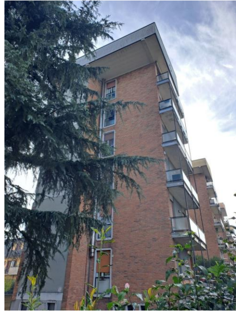
2. Panoramica del condominio
