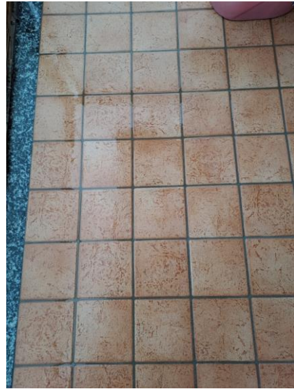
20. Pavimento del balcone
