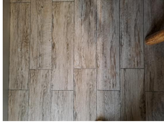
36. Pavimento della cucina/soggiorno
