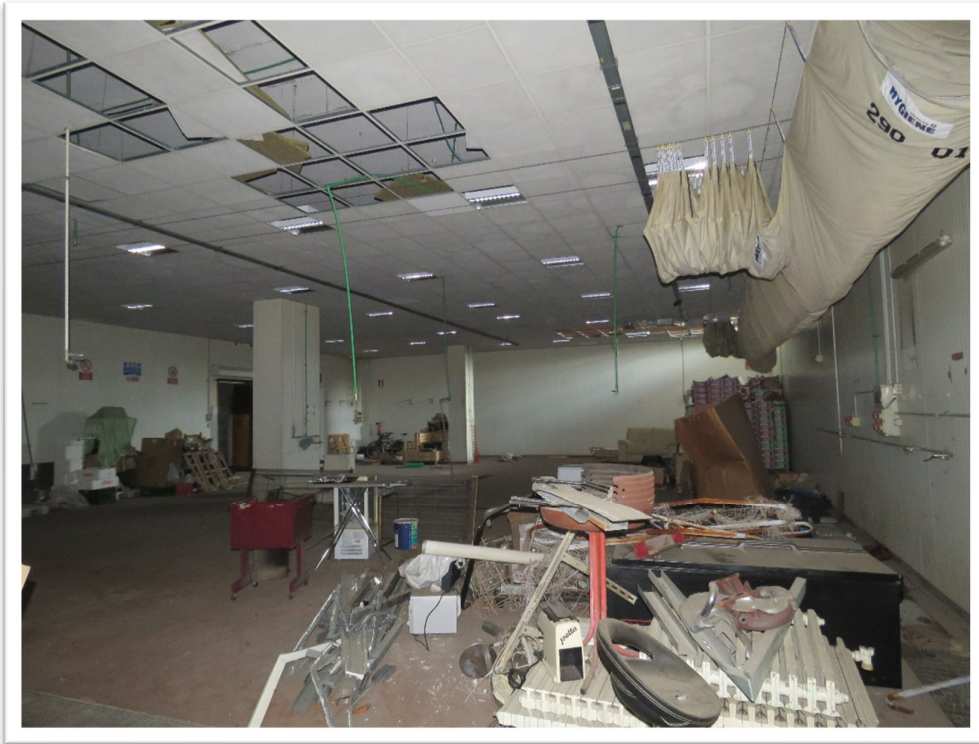
Vista interna del capannone CORPO 1 ).
