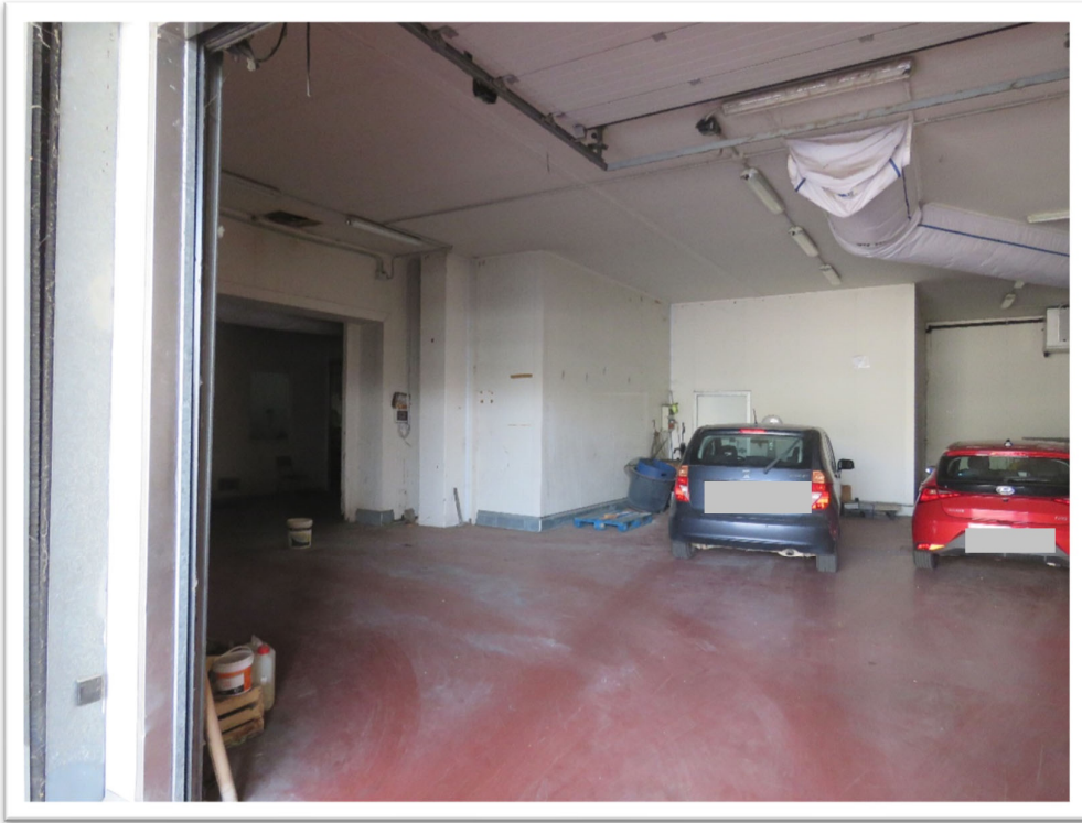
Vista interna della tettoia CORPO 2 ).
