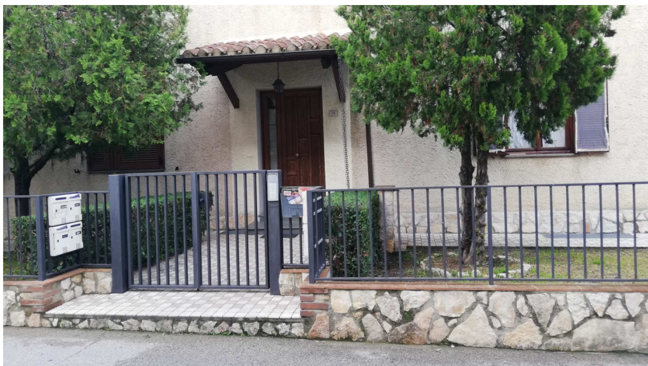
2) Ingresso al fabbricato
