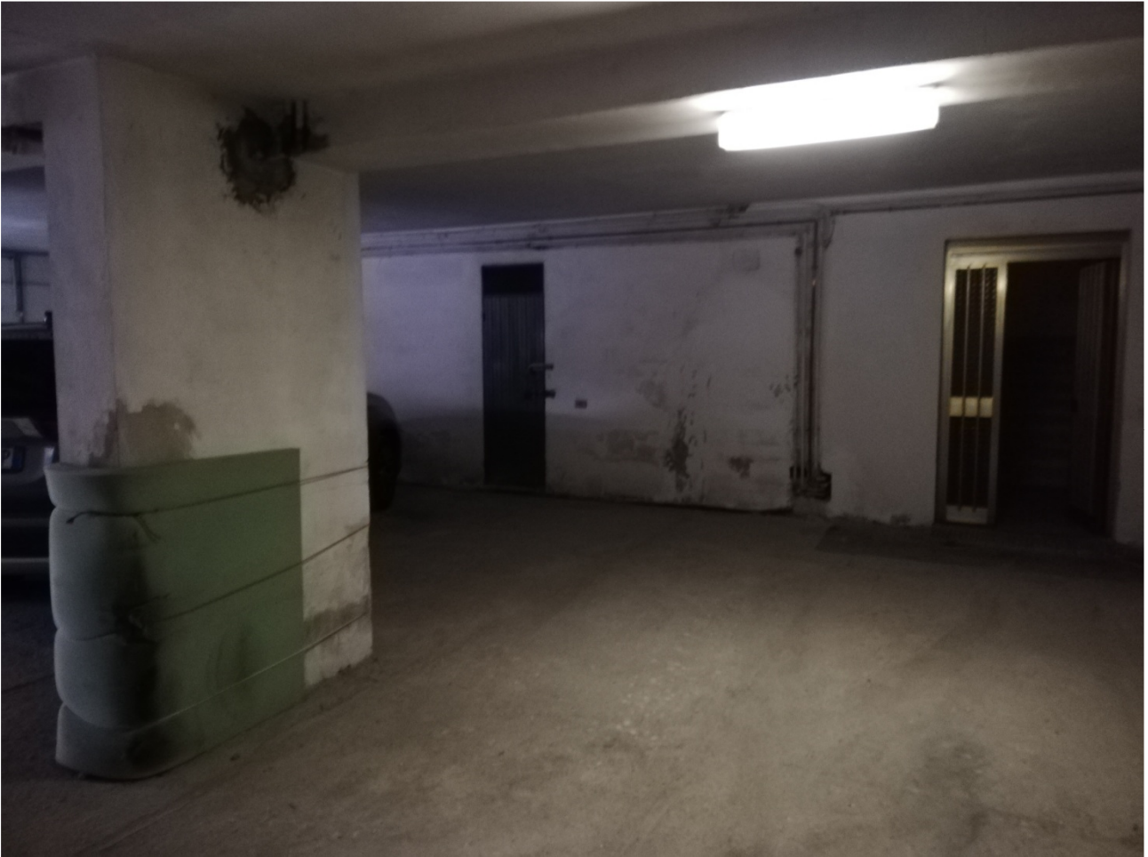
12) Vista esterna cantina al piano interrato
