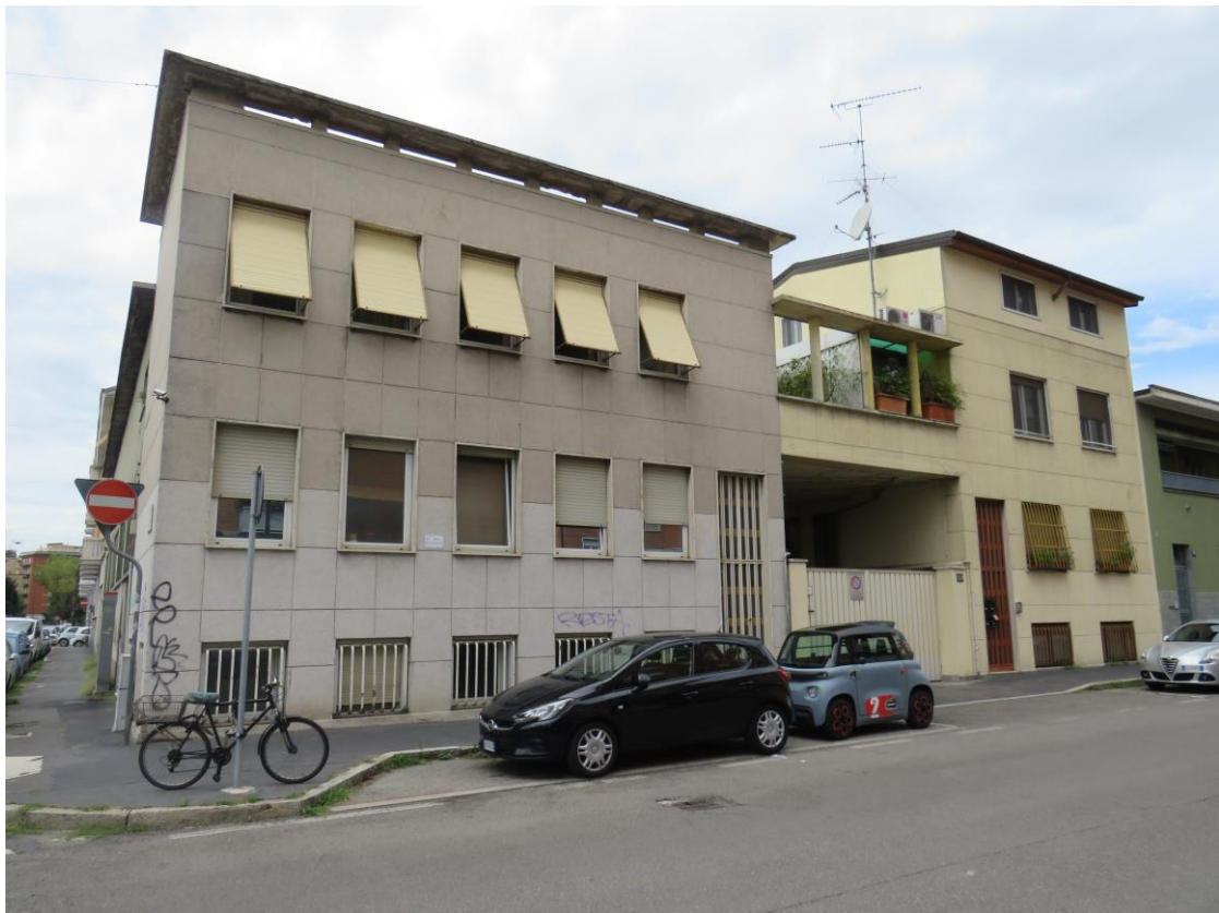
FACCIATA SU VIA PRIVATA ANGIOLO MAFFUCCI
