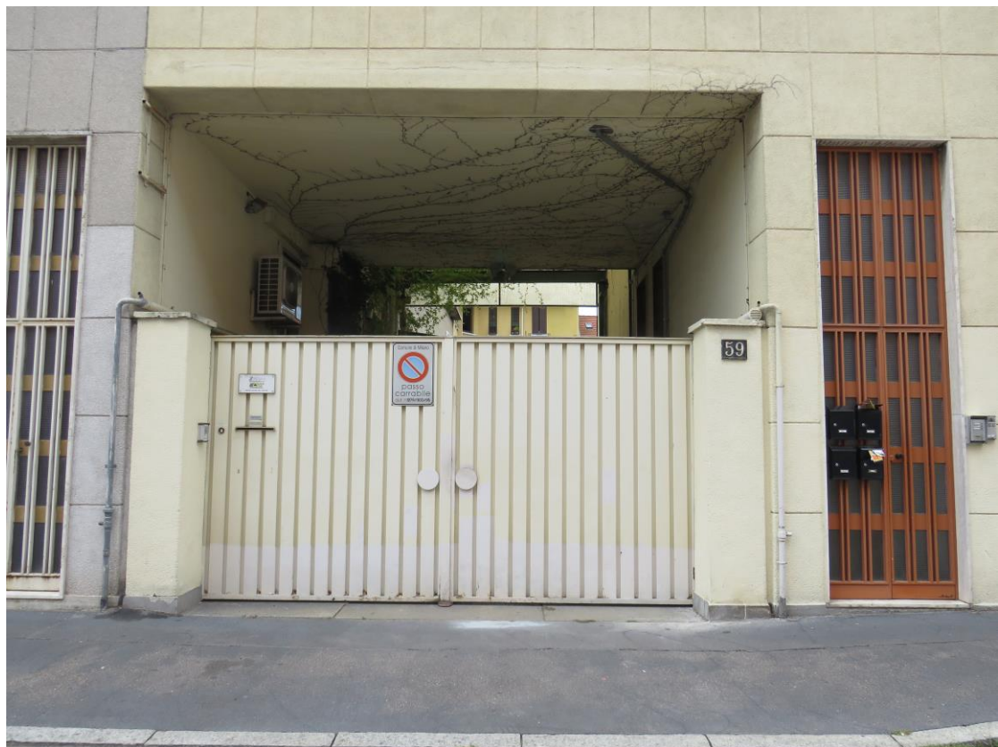
PORTONE PEDONALE E CARRAIO
